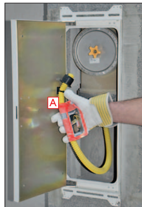
Ableitung (A) zum Abwasserkanal bauseits erstellen.
