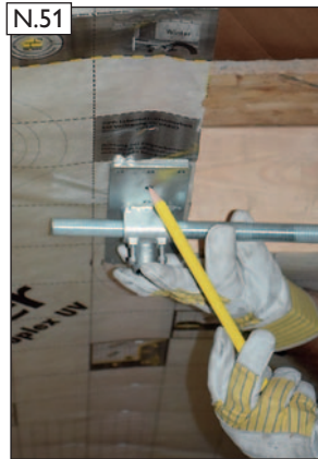
N.51 Aufgefädelte Einzelteile zum einrichten anhalten. Einbauposition für den Sparrenhalter markieren. Danach Einzelteile aus-fädeln.
