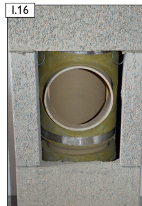
I.16 Ansicht vor dem Anbringen der Putztür.
