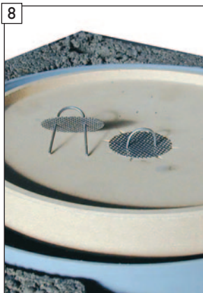
Ein Grobfilter ist in der Fußschale eingesteckt. Dieser ist regelmäßig von Grobschwebeteilchen zu reinigen.
