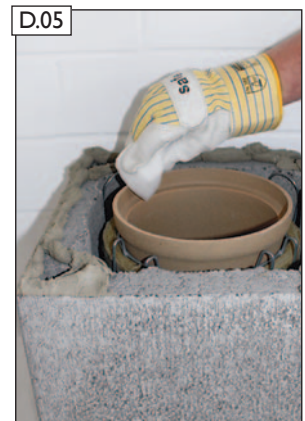
Steckverbindung säubern.
