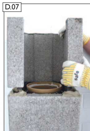
RA-Öffnungsstein versetzen.
