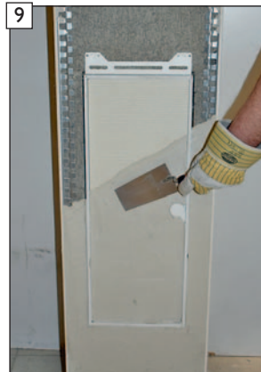
9 Anbringen des bauseitigen Unterputzes auf den Design-Fertigfuß und den Putzträger der BlowerDoor Design-Fertigfußtür.
