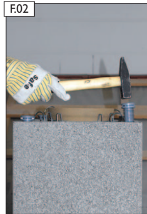
HEB-Spezialdübel in die Bewehrungskanäle des Mantelsteins einschlagen.
