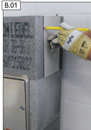
B.01 RA-Schnittschablone anlegen, Mantelsteinöffnung anzeichnen.
