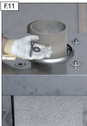
F11 Montagerihenfolge: 1. Silikondichtungen 2. Edelstahl-Unterlegscheiben
