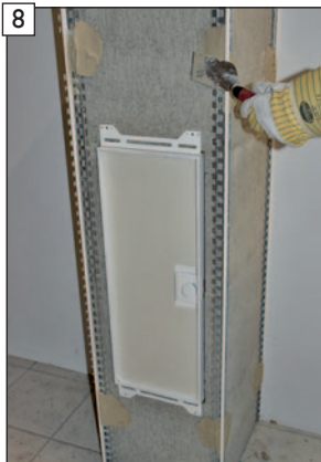
8 Anbringen der bauseitigen Putzschienen.
