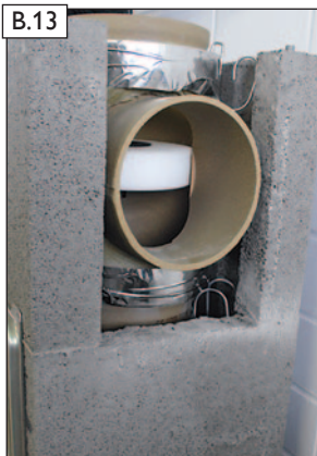
B.13 RAPID-Fugendichtreste mit Fugenglätter abstreifen.
