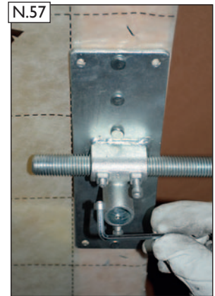
N.57 Gewindestange fixieren. Dazu die Abreißschrauben an beiden Sparrenhaltern mit Inbusschlüssel (F) anziehen bis der Schraubkopf an der Sollbruchstelle abreißt. Erst danach Spannwinkel fixieren (siehe Bild N.58).
