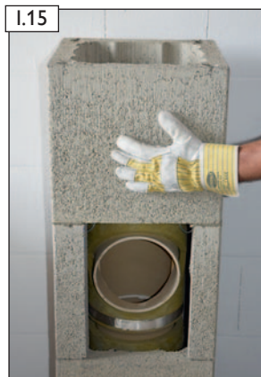
I.15 Weiteren Mantelstein versetzen.
