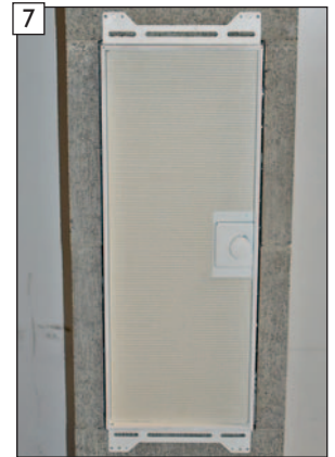
7 Fertigansicht mit vollständig eingebrachter Schutzdichtung.
