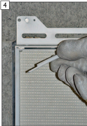
4 Detailansicht Bereich Türscharnier mit bauseits zurückgeschnittener Schutzdichtung im Bereich des Türscharniers.
