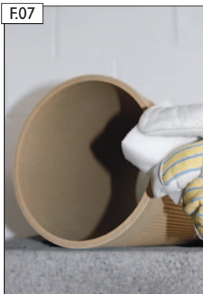
F07 Unterseite zugeschnittenes Abschluss-Profilrohr (ohne Dämmschale) säubern.
