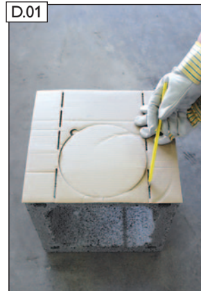
RA-Schnittschablone außen anlegen, Mantelsteinöffnung anzeichnen.
