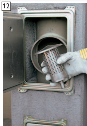
TIPP! Wir empfehlen den patentierten Kondensattellerfilter (Art.-Nr.: 157327) zum sicheren Schutz vor Verstopfungen in den Ablaufleitungen!
