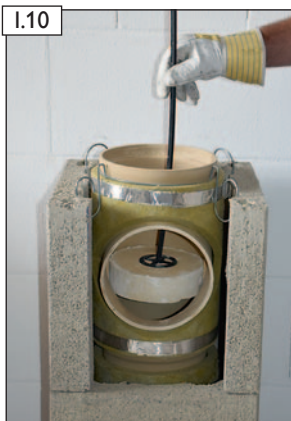
I.10 RAPID-Fugendichtreste mit Fugenglätter abstreifen.
