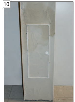
10 Fertigansicht bauseitiger Unterputz. WICHTIG! Trockenzeiten gem. den Herstellervorgaben beachten!
