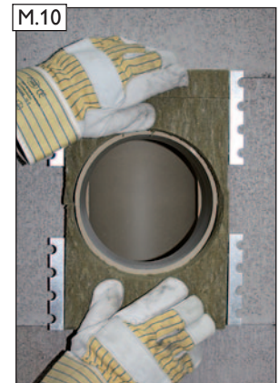
M.10 Jetzt die zugeschnittene BDF in die Mantelsteinöffnung einbringen und ...
