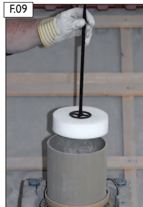
F09 RAPID-Fugenkittreste abstreifen.
