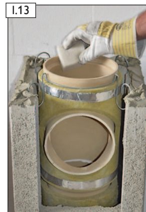
I.13 Steckverbindung säubern.
