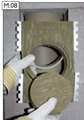
M.08 Inneren Stützkern entfernen.
