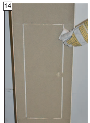
14 Schutzdichtung mit Schwamm nacharbeiten.
