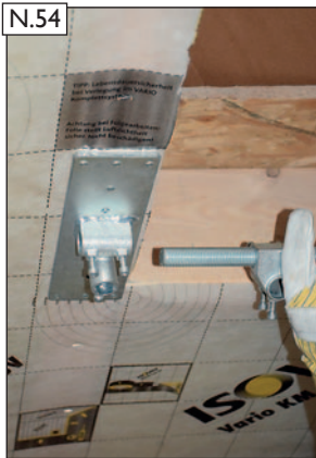
N.54 Gewindestange und 45° Spannwinkel wieder ein-fädeln und ausrichten.
