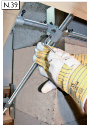
Zuerst Sparrenhalter und Spannwinkel (siehe Bild N.24 und N.25), danach Spannkreuz fixieren. Abreißschrauben anziehen bis Schraubkopf an der Sollbruchstelle abreißt.
