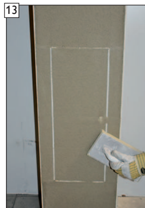
13 ... dabei die Schutzdichtung bündig freireiben.
