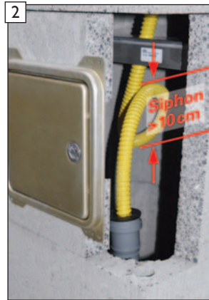
Ableitung mit HT-Rohren DN40 mit Aufweitungen zum Bodenablauf innerhalb des Schornsteins. Hierzu die Dichtung (A) der Blende (B) in die Muffe des HT-Rohres DN40 einbringen.
