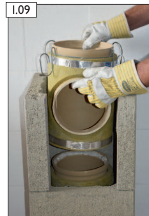
I.09 PA-Formstück einsetzen.
