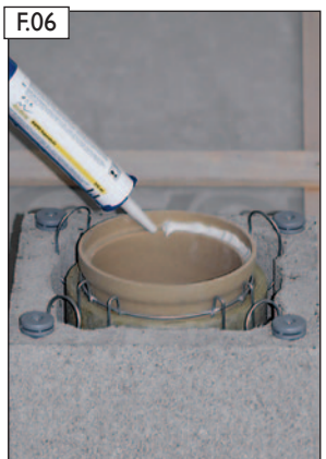
RAPID-fugendicht satt auftragen.
