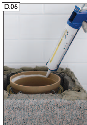
RAPID-fugendicht satt auftragen.
