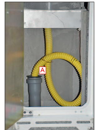
Ableitung (A) zum Abwasserkanal bauseits erstellen.
