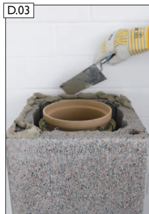
Mörtel MG(M5) IIa (Mauermörtel nach EN 998-2) auftragen.
