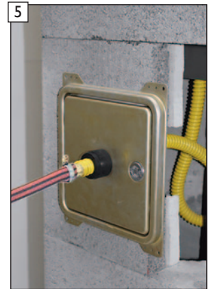
Beispiel: bauseitige Ableitung mittels Schlauch 3/4"
