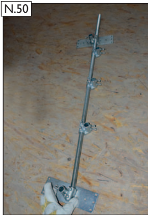
N.50 Zweiten Schornsteinhalter vorbereiten. Spannkreuze und Sparrenhalter lose auf die Gewindestange auf-fädeln.
