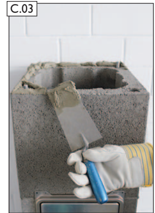
Mörtel MG(M5) IIa (Mauermörtel nach EN 998-2) auftragen.
