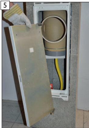
5 Türblatt vorsichtig entfernen. ACHTUNG! Umlaufende Innendichtung nicht beschädigen!
