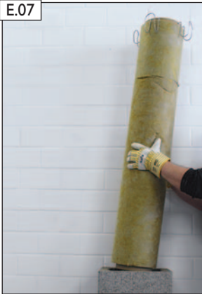
Profilrohr 133 cm einsetzen.
