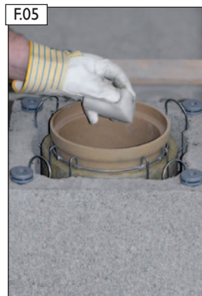
Steckverbindung säubern.
