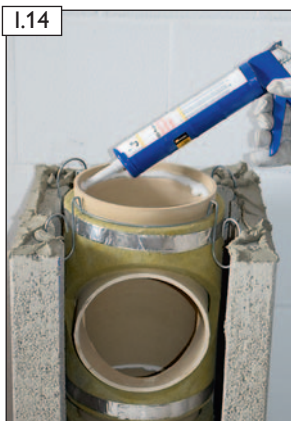
I.14 RAPID-fugendicht satt auftragen.
