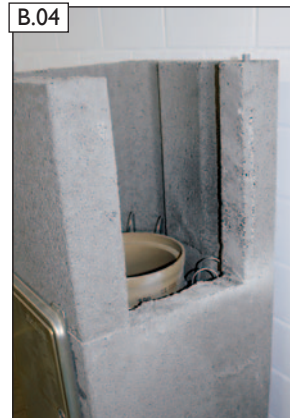
B.04 Fertigfuß von allen Bauschuttresten säubern.
