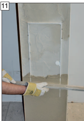
11 Bauseitigen Oberputz auftragen.
