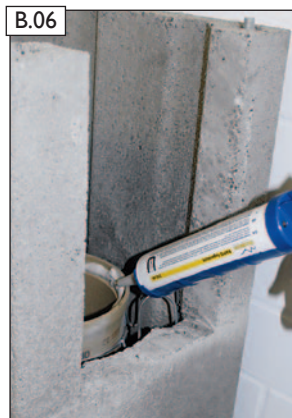
B.06 RAPID-fugendicht satt auftragen.
