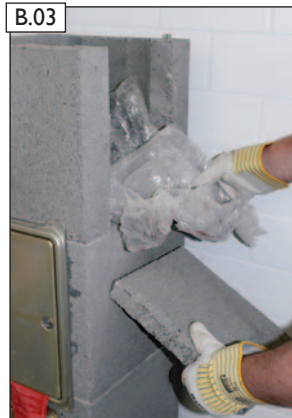
B.03 Bauseitige Schutzabdeckung entfernen.
