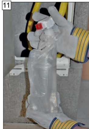
Kondensatauffangbeutel vorsichtig herausziehen.
