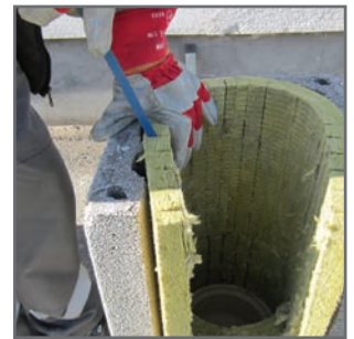
8.3- 8.4 A nyílással ellátott köpenytéglát felhelyezzük. A felesleges habarcsot lehúzzuk, a nyitott felfekvésű hézagokat teljesen eltömítjük. Meghajlítjuk és behelyezzük a szigetelő lapokat. Az előlő szellőztető csatornákat szabadon kell hagyni, ezért a hőszigetelő lapot le kell vágni.
