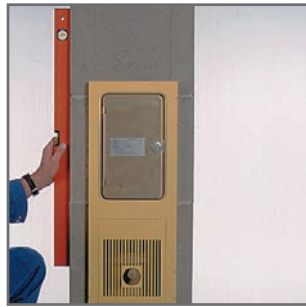
7.2 A kéménytalpat függőlegesen a habarcsba állítjuk.
