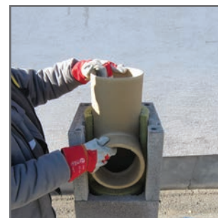
9.4 Behelyezzük a csatlakozót
