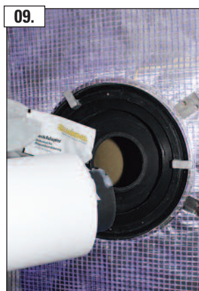
09. Konzentrische Verbindungsleitung mit Gleitmittel versehen und montieren.
