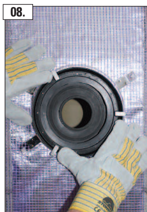
08. Äußeren Steckadapter mit Gleitmittel in Putzring einsetzen.
