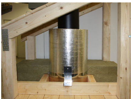
PROTECT BOX instalovaný do dřevěné střešní konstrukce
