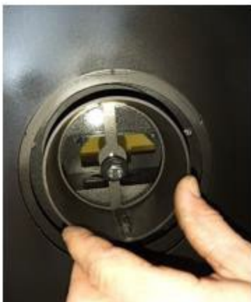
Ukázka montáže, uchycení přívodu vzduchu
