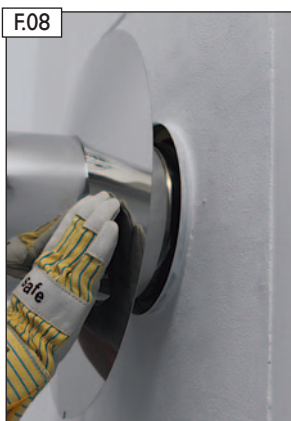
Installer tilslutningsrøret i overensstemmelse med monteringsvejledningen.
