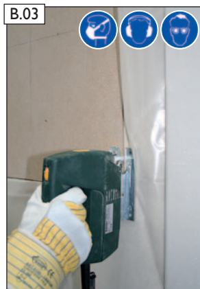
Tilskær væggen det nødvendige hulmål. OBS! Bærende elementer må ikke svækkes. Husk nødvendig sikkerhedsudstyr
