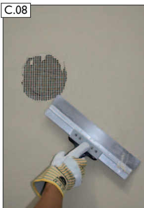
Udjævnning af overfladen.
