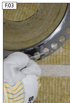
F.03 Fastgør regnkraven med søm i rustfrit stål (skal leveres af kunden).
