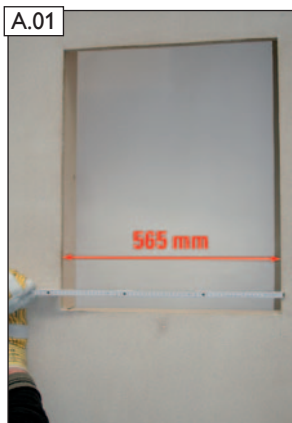
Påkrævet fri monteringsbredde 565 mm.
