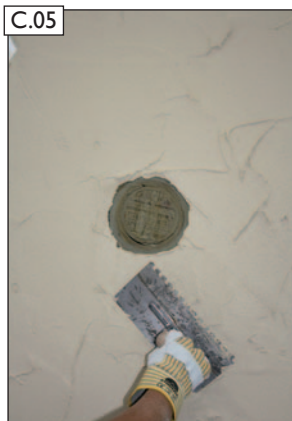
Udjævn puds/spartelmasse til en jævn heldækkende overflade.
