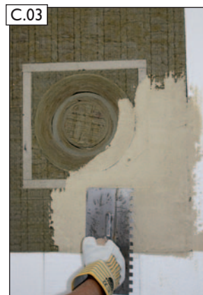
Påfør kun pudslaget på ydersiden af IGNIS PROTECT. OBS! Indvendige rørsåle må ikke dækkes med gipsplader eller pudslag.
