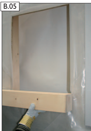
Monter understøtning til IGNIS PROTECT i trækonstruktionen.
