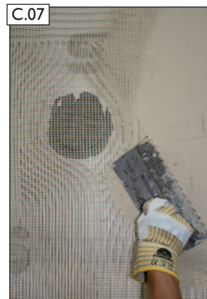
Indlejr nettet i puds/spartelmassen.
