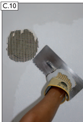
Påføring af afsluttende puds.
