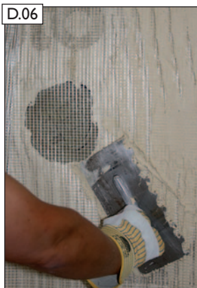
D.06 Indlejr nettet i puds/spartelmassen
