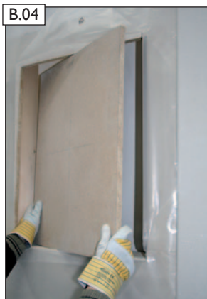
Fjern træbaserede paneler, isolering osv. fra udskæringen.
