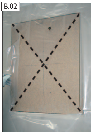
Skær dampspærre op på tværs til det ønskede åbningsmål (se figur A.1 og A.2).
