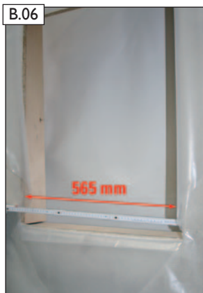
Tjek åbningsbredden på 565 mm OBS! IGNIS PROTECT MÅ IKKE TILSKÆRES!
