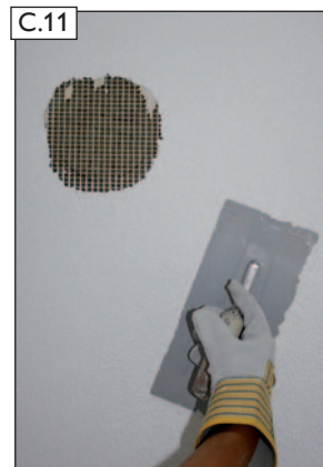
Strukturering af den afsluttende puds.
