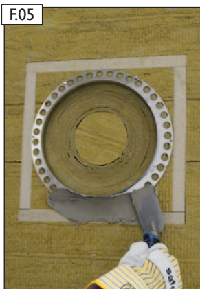
Udjævn pudslag på ydersiden af væggen
