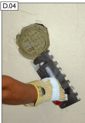
D.04 Færdig niveau af overfladebehandling puds/spartelmasse
