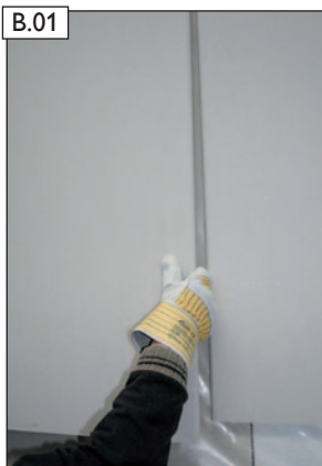
Fjern gipspladen. OBS! Dampspærren må ikke blive beskadiget!
