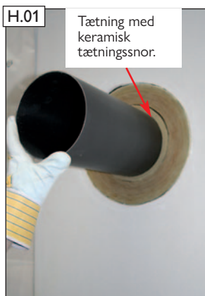
T450 Eksempel med enkeltvægget røgrør.
