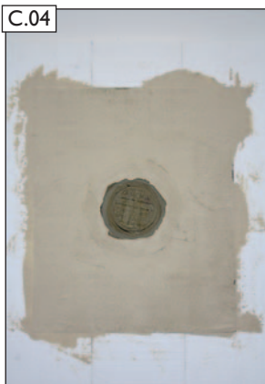
Færdig overfladebehandling puds/spartelmasse.
