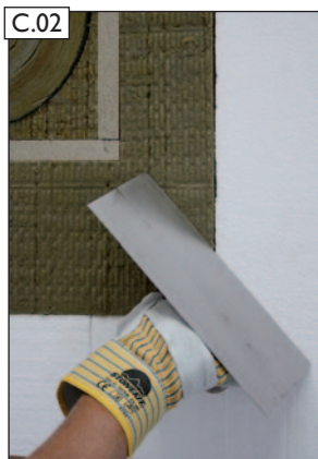
Tjek Isoleringen på stedet, så den passer ind.
