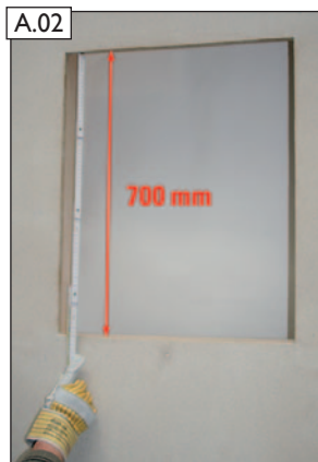
Påkrævet fri monteringshøjde 700 mm.
