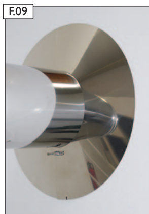
Monter dækslet i flugt med ydervæggen i overensstemmelse med monteringsvejledningen.
