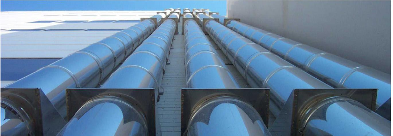
Das Abgassystem ICS 5000 aus hochwertigem Edelstahl ist die perfekte Lösung, wenn es um Unter- und/oder Überdrucke bis 5000 Pa und hohe Abgastemperaturen geht. Anwendbar im Innen- und Außenbereich bietet es ein breites Einsatzspektrum, z. B. für industrielle Anwendungen, Heizanlagen, Dieselgeneratoren sowie Notstromaggregate.
