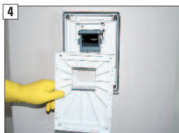
4 Die innere Abdeckung des Abluftelementes entfernen.
