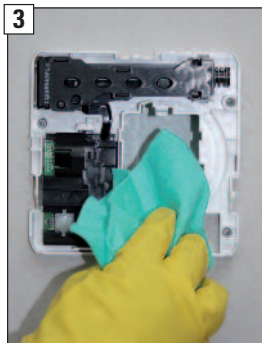
3 Öffnungen des Abluftelementes mit einem Staubtuch reinigen.
