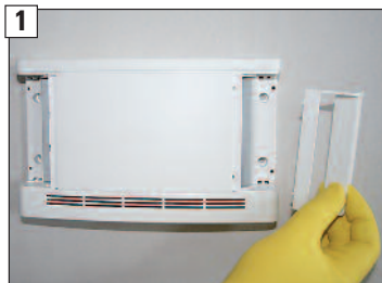
1 Öffnungsklappen des Zuluftelementes entfernen.
