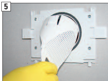
5 Insektenfang herausziehen und reinigen.
