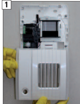
1 Gehäusedeckel des Abluftelementes entfernen.
