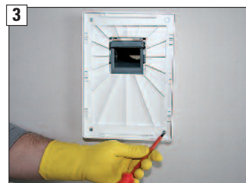
3 Die 4 Schrauben der inneren Abdeckung lösen.
