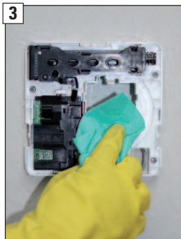
3 Öffnungen des Abluftelementes mit einem Staubtuch reinigen.
