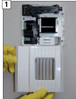
1 Gehäusedeckel des Abluftelementes entfernen.
