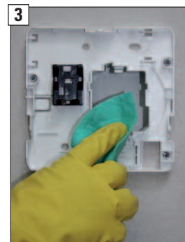
Öffnungen des Abluftelementes mit einem Staubtuch reinigen.
