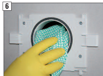
6 Öffnung der Grundplatte mit einem Staubtuch reinigen.
