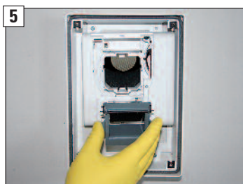
5 Mit 2 Fingern den Klappenkasten nach vorne herausnehmen.
