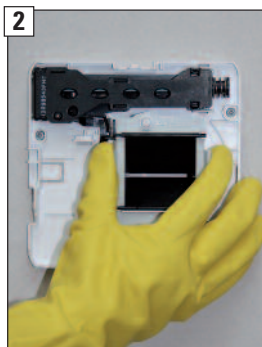
Klappenkasten mit 2 Fingern nach vorne herausnehmen.
