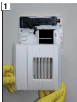
Gehäusedeckel des Abluftelementes entfernen.
