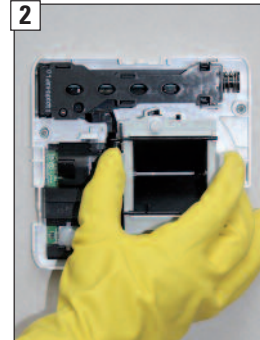
2 Klappenkasten mit 2 Fingern nach vorne herausnehmen.
