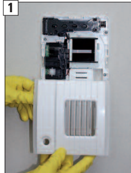
1 Gehäusedeckel des Abluftelementes entfernen.
