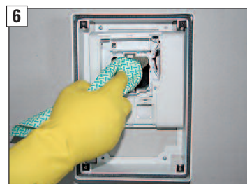
6 Die Öffnungen des Abluftelementes mit einem Staubtuch reinigen.
