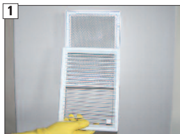
1 Abdeckung des Abluftelementes entfernen.
