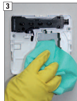
Öffnungen des Abluftelementes mit einem Staubtuch reinigen.
