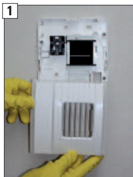
Gehäusedeckel des Abluftelementes entfernen.
