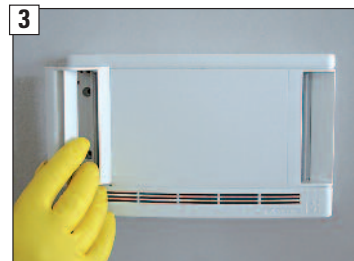
3 Öffnungsklappen wieder einsetzen.
