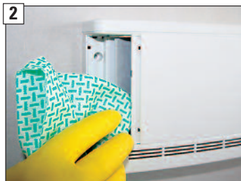
2 Öffnungen des Zuluftelementes mit einem Staubtuch reinigen.
