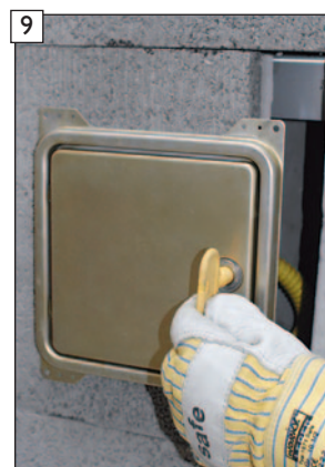
9 Kondensatblendentürblatt wieder verschließen.
