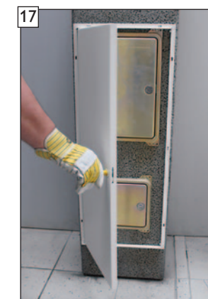
17 Kunststoffkeile entfernen und Funktionskontrolle der Tür durchführen.
