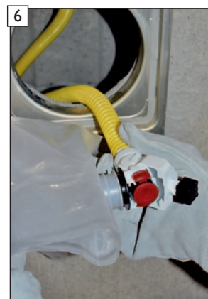
6 BIB-Anschluss hahn des Kondensatauffangbeutels in die Aufnahme des Kupplungsteils vom BIB-Connector einstecken.
