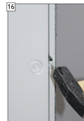
16 Schlagdübel einsetzen und einschlagen. ACHTUNG! Lackierung dabei nicht beschädigen.
