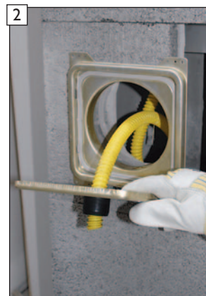
2 BlowerDoor Kondensatblendentürblatt abnehmen und Adapter für HT-Rohrverbindung DN40 mit Siphonschlauch herausziehen.
