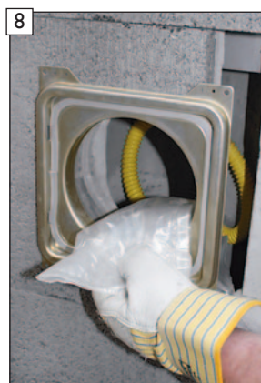
8 Siphonschlauch und Kondensatauffangbeutel in Schornsteinfuss einschieben.
