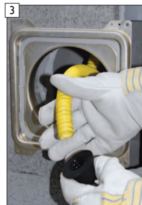
3 Adapter für HT-Rohrverbindung DN40 vom Siphonschlauch abschrauben.
