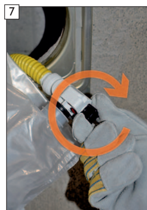
7 Verriegelung des BIB-Connectors im Uhrzeigersinn schließen.
