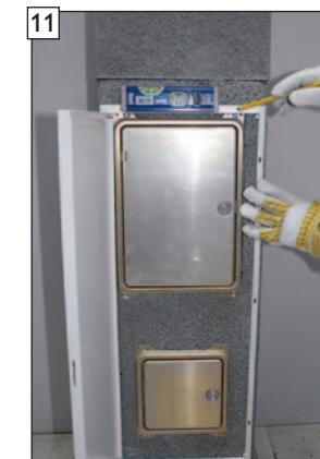
11 Blendenrahmen lotrecht ausrichten.
