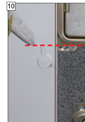
10 WICHTIG! Verschlusshebel im Türblatt darf nicht zu hoch positioniert werden damit dieser nicht am Putzrahmen anschlägt.
