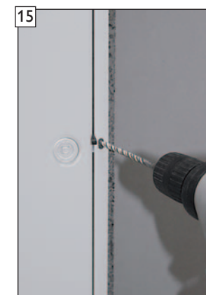
15 Erst jetzt, im zweiten Arbeitsschritt, die beiden mittigen Bohrlöcher vorbereiten.
