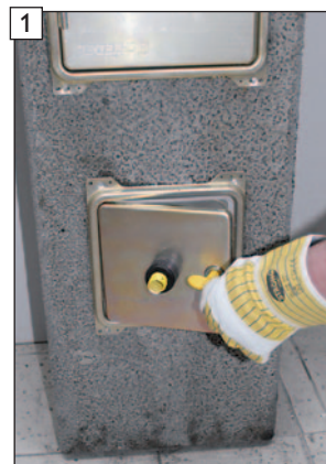
1 Kondensatblendentürblatt öffnen.
