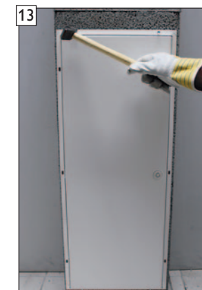
13 Schlagdübel in die beiden oberen und unteren Befestigungslöcher einsetzen und einschlagen.
