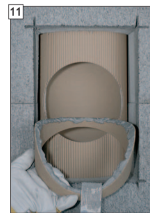
11 Nach Reinigen beider Kittflächen Schiedel-Fugenkitt auf die Putztürzarge auftragen.
