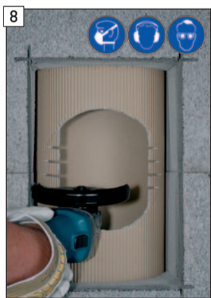
8 Verbliebene seitliche Profilrohrsegmente streifenförmig einschneiden. Streifenbreite ca. 10-15 mm.
