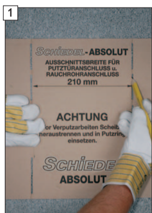
1 Unter Verwendung der Schnittschablone Mantelsteinöffnung anreißen.
