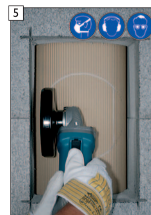
5 Entlang der Markierung Sollbruchstelle mit Winkelschleifer anschneiden. Seitlich nicht erreichbaren Bereich später bearbeiten (Bild 8 und 9).
