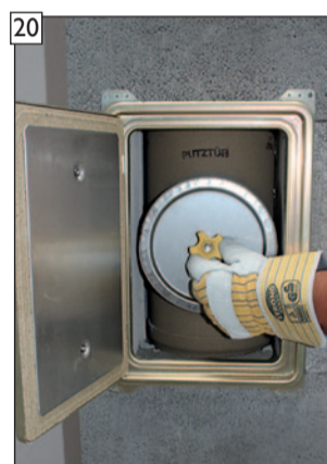
Putztür annageln und Verschlussdeckel einsetzen. WICHTIG! Trockenzeit des Fugenkitts (ca. 48 Std.) beachten!
