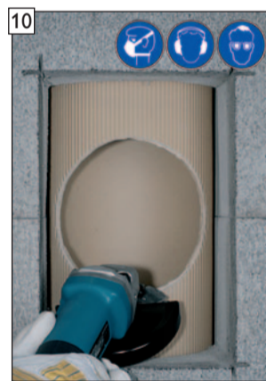
10 Unebenheiten an der Sollbruchstelle mit Winkelschleifer nacharbeiten.
