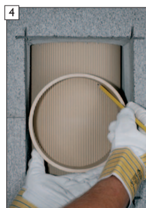
4 Putztürzarge als Schablone verwenden und entlang des inneren Durchmessers anreißen.
