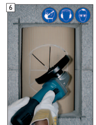
6 Das Profilrohr sternförmig mit Winkelschleifer einschneiden.
