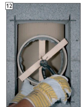
12 Putztürzarge am Profilrohr feströdeln.
