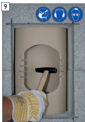
9 Restliche Profilrohrteile vorsichtig mit Hammer entfernen.
