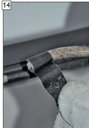
14 Abgeschnittenes Ende mit Klebeband für Dichtstoß sichern.
