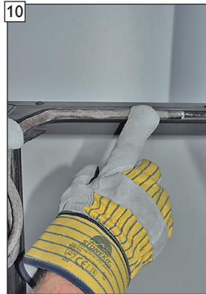
10 Runddichtung mittig in der Rille im Bereich der oberen Halteleiste ansetzen und mit leichtem Druck einbringen.
