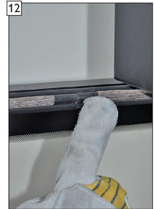
12 Dichtbandstoß spaltfrei ausführen.
