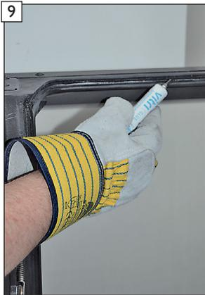
9 Kleber umlaufend in die Rille der Halteleiste auftragen.
