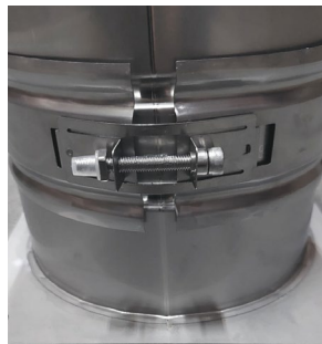
2. Alle Elemente kraftschlüssig mittels Klemmband verbinden.
