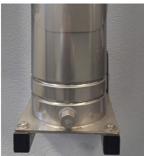
1. Fundamentverankerung auf Wandkonsole verschrauben und auf vorher ermittelter Höhe an der Wand befestigen. Kondensatschale und Reinigungs-/ Inspektionselement montieren.
