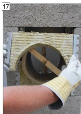
17 Haltewinkel auf Mineralfaserfrontplatte aufstecken und einbauen.
