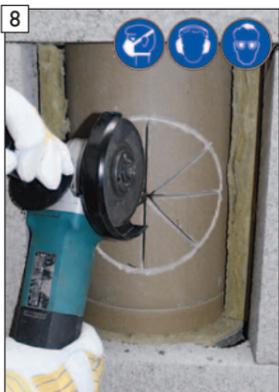
8 Mit Winkelschleifer sternförmig das Schamotterrohr einschneiden.
