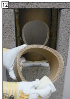
12 Rauchrohrstutzen mit feuchtem Schwamm säubern.
