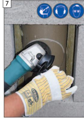
7 Äußeren Querschnitt mit Winkelschleifer als „Sollbruchstelle“ anschneiden.
