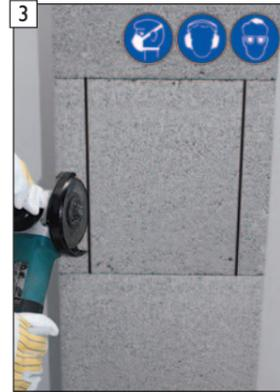
3 Mantelstein mit Winkelschleifer an den Markierungslinien aufschneiden.
