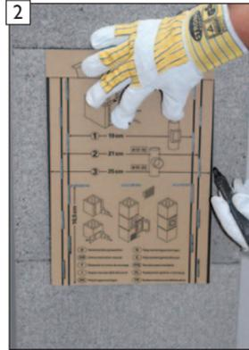
2 Unter Verwendung der Schnittschablone Mantelsteinöffnung anreißen.
