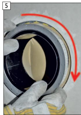
Anschlussfutter mit aufgewickelter E-Glas Flachdichtung in das Schamotteanschlussformstück in Wickelrichtung hineindrehen.
