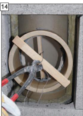
14 Rauchrohrstutzen am Schamotterrohr feströdeln.
