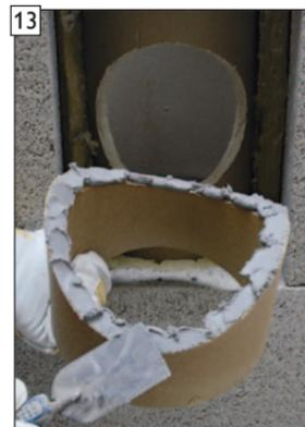
13 Schiedel-Fugenkitt auf Rauchrohrstutzen auftragen.
