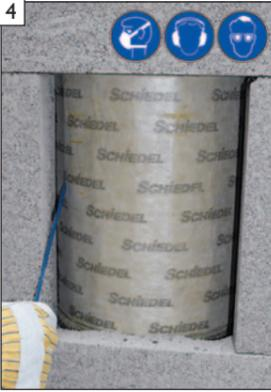
4 Dämmung mittels Sägeblatt entlang der Hinterlüftungskanäle aufschneiden ...
