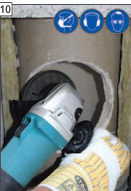
10 Unebenheiten an der Sollbruchstelle mit Winkelschleifer nacharbeiten.
