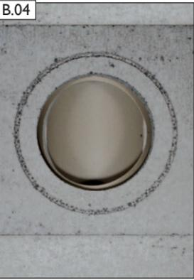
Ansicht durchbohrter Mantelstein und Schamotterrohr.
