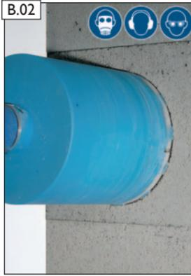
Mantelstein mit der größten Bohrkronen (Bohrkronen ca. 4 cm größer als der Rauchrohrstutzen-Außendurchmesser) max. 10 mm tief anbohren (dient als spätere Führung für die größere Bohrkronen).
