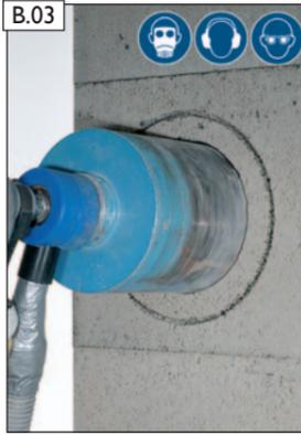
Für den inneren Querschnitt mit kleinerer Bohrkronen (Durchmesser ist Rauchrohrstutzen-Innendurchmesser), vorsichtig durch Mantelstein und Schamotterrohr bohren.
