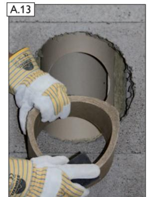
A.13 Rauchrohrstutzen mit feuchtem Schwamm säubern.
