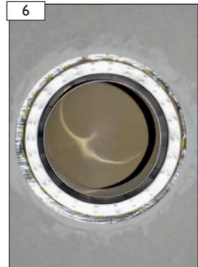
Fertigansicht des eingebauten Anschlussfutters mit E-Glas Flachdichtung.
