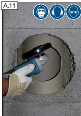
A.11 Unebenheiten an der Sollbruchstelle mit Winkelschleifer nacharbeiten.
