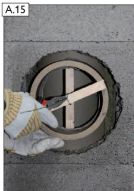
A.15 Rauchrohrstutzen am Schamotterrohr feströdeln.
