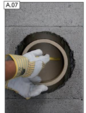
A.07 Rauchrohrstutzen als Schablone verwenden und entlang des inneren Durchmessers anreißen.
