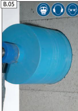
Mantelsteinöffnung jetzt mit größerer Bohrkronen vollständig aufbohren. **WICHTIG!** Schamotterrohr dabei nicht beschädigen oder anbohren!
