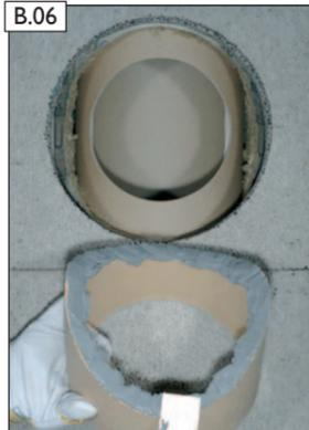
Nach Reinigung beider Kittflächen Schiedel-Fugenkitt auf die Rauchrohrstutzen auftragen.
