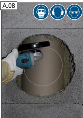
A.08 Markierung mit Winkelschleifer als "Sollbruchstelle" anschneiden.
