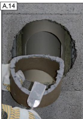
A.14 Schiedel-Fugenkitt auf Rauchrohrstutzen auftragen.
