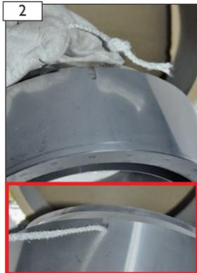
An einem Ende der E-Glas Flachdichtung einen Knoten binden und das Knotenende der E-Glas Flachdichtung in den Knotenfänger des Anschlussfutters einhängen.
