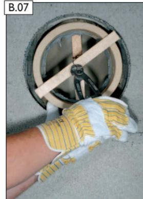
Rauchrohrstutzen am Schamotterrohr feströdeln.
