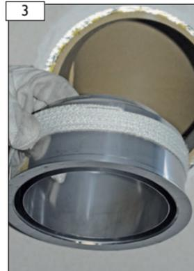
E-Glas Flachdichtung spiralförmig und straff um das Anschlussfutter wickeln. **WICHTIG!** Ende der E-Glas Flachdichtung am Schluss festhalten!
