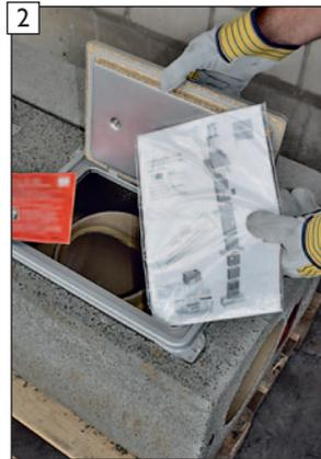
2 Die ABSOLUT-Versetzanleitung ist hinter der Putztür beigepackt.
