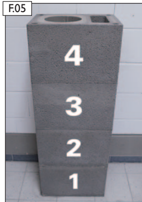
Vier Mantelsteine jeweils in Dünnbettmörtel versetzen.
