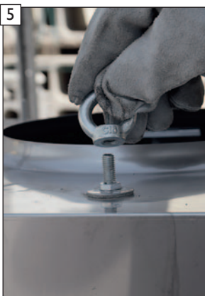
5 Ringösen können nun entfernt werden.
