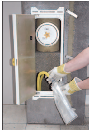
Fertigansicht mit angeschlossenem Kondensatauffangbeutel.
