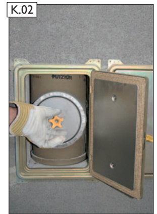
K.02 Standardrevisionsverschluss einsetzen.
