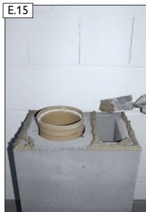
E.15 Dünnbettmörtel auftragen.
