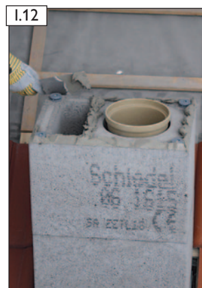
I.12 Mörtelbett MG(M5) IIa (Mauermörtel nach EN 998-2) auftragen.
