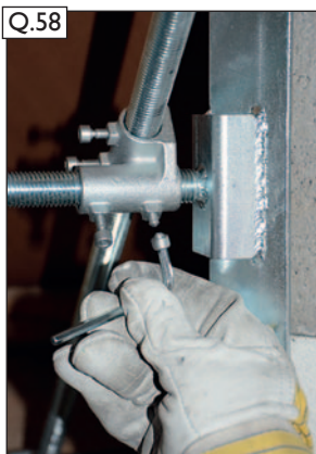
Q.58 Spannwinkel an den Schornstein drücken. Abreißschrauben anziehen bis der Schraubkopf an der Sollbruchstelle abreißt.
