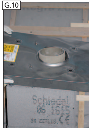
G.10 Zuluftkopfplatte-Edelstahl auflegen.
