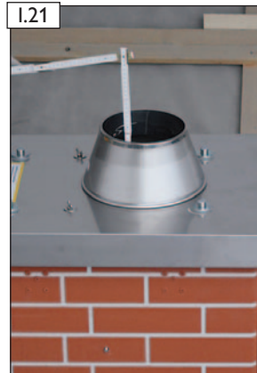
I.21 ... Zuschnittlänge für das letzte Profilrohr ermitteln.
