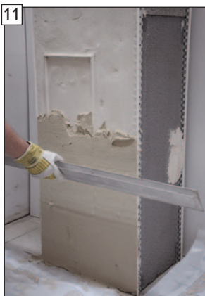
11 Bauseitigen Oberputz auftragen.
