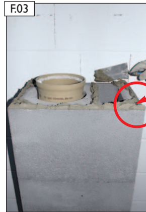
Dünnbettmörtel auftragen.
