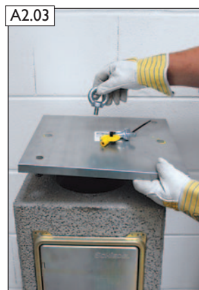
Ringschrauben und Abdeckung entfernen.
