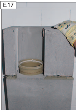
Öffnungsstein versetzen.
