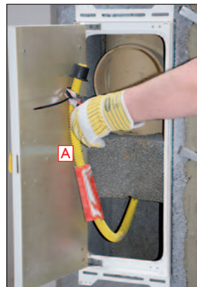
Ableitung (A) zum Abwasserkanal bauseits erstellen.
