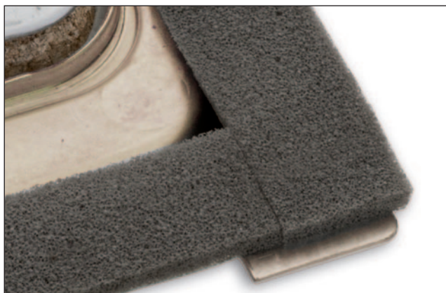
Dichtband im Eckbereich ohne Spalt aufkleben.
