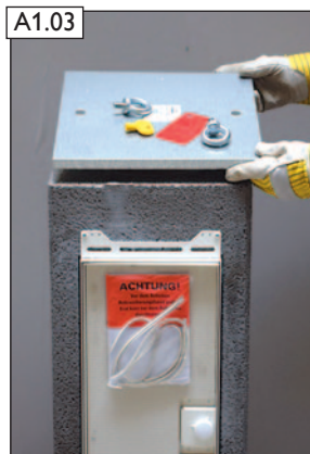
Ringschrauben und Abdeckung entfernen.
