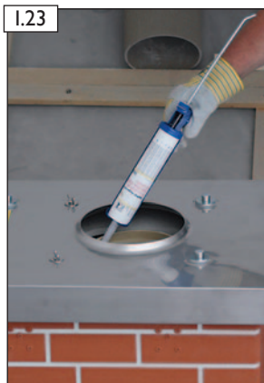
I.23 RAPID-fugendicht satt auftragen.
