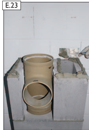
Dünnbettmörtel auftragen.
