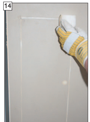
14 Schutzdichtung mit Schwamm nacharbeiten.
