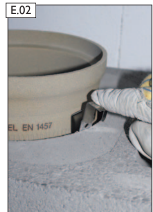
E.02 Abstandhalter (3 Stück) auf den Umfang verteilt in die integrierte Wärmedämmung aus Schaumbeton eindrücken.
