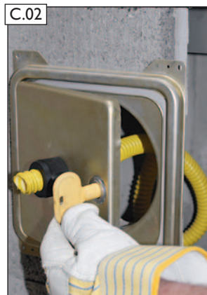
C.02 Kondensatblendentürblatt öffnen.
