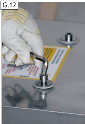
G.12 3. Edelstahl-Inbusschrauben M12 handfest anziehen.
