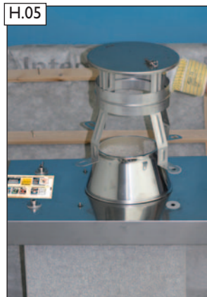
Silikondichtungen auf Zuluftkopfplatte-Edelstahl auflegen. Regenhaube „EAGLE“ aufsetzen.
