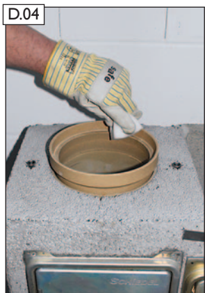
D.04 Steckverbindung säubern.
