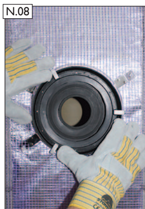
Äußeren Steckadapter mit Gleitmittel in Putzring einsetzen.
