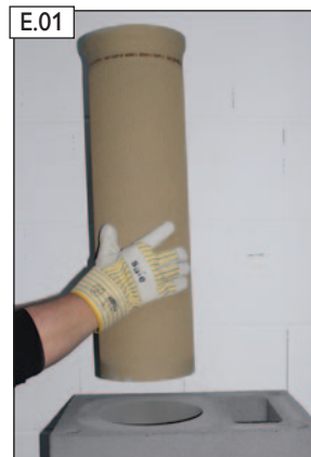
E.01 Profilrohr (L= 66 cm - aus dem RA-Paket entnehmen) versetzen.
