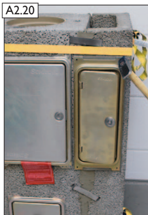
Vorbereitete Revisionstür auf Lüftungsmodul annageln.
