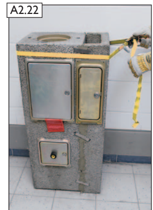
Spanngurte lösen. HINWEIS! Die Spanngurte werden im weiteren Versetzvorgang nicht mehr benötigt!
