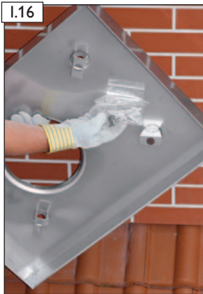
Befestigung für Regenhaube von der Edelstahl-zuluftplatte entnehmen.
