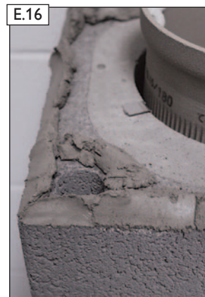
E.16 ACHTUNG! Auf geschlossenen Stegbereich achten!
