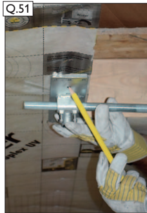
Q.51 Aufgefädelt Einzelteile zum einrichten anhalten. Einbauposition für den Sparrenhalter markieren. Danach Einzelteile ausfädeln.
