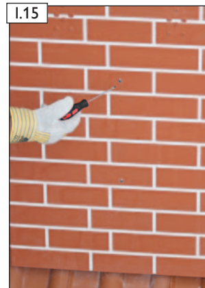
Gewindestifte kraftschlüssig verschrauben.
