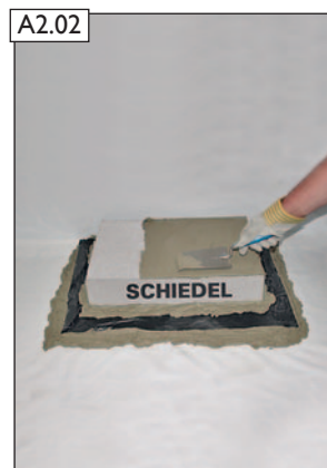
Mörtelbettaufbau bei ergänzender Verwendung der ABSOLUT-Thermofußplatte (nicht im Lieferumfang enthalten).
