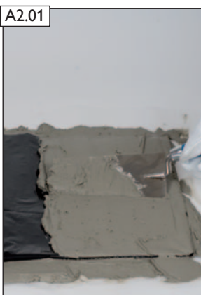
Mörtelbett MG(M5) IIa (Mauermörtel nach EN 998-2) für Fertigfuß und Lüftungsmodul vorbereiten, Feuchtesperre einlegen, Mörtel auftragen.
