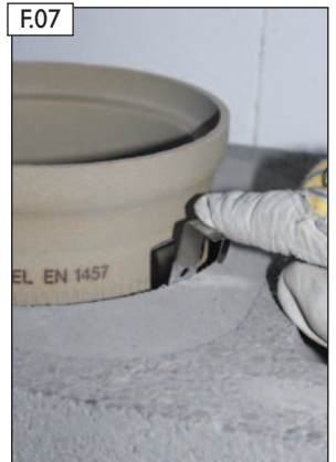
Abstandhalter (3 Stück) auf den Umfang verteilt in die integrierte Wärmedämmung aus Schaumbeton eindrücken.
