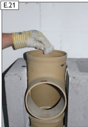
Steckverbindung säubern.
