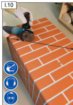
Schrägschnitt mit Flex herstellen.
