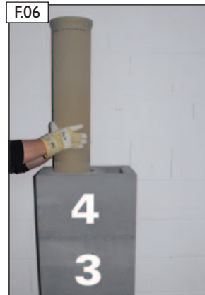
Profiltröhr (L = 133 cm) einsetzen.
