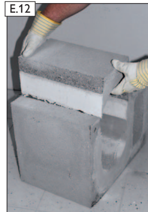
E.12 Mantelsteinscheibe herausnehmen. Mögliche in der Montageöffnung überstehende Dämmstoffreste entfernen.
