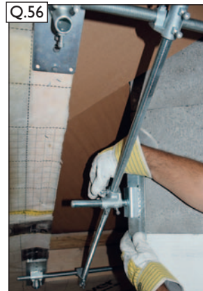
Q.56 Spannwinkel ausrichten und vorfixieren.
