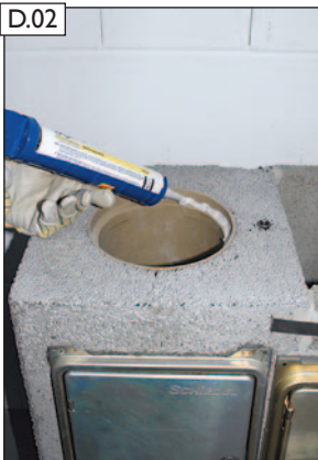
D.02 RAPID-fugendicht satt auftragen.
