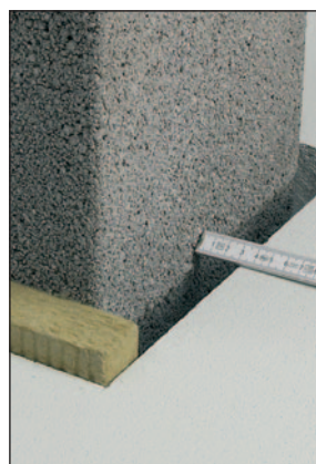
Montageausparung allseitig 3 cm größer als Mantelsteinmaß.
