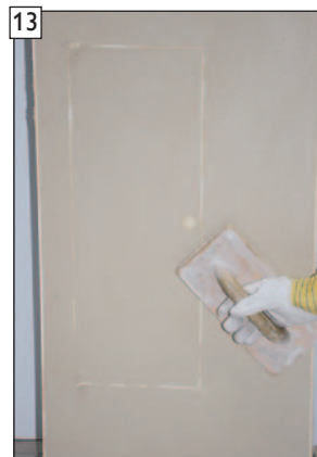
13 ... dabei die Schutzdichtung bündig freireiben.
