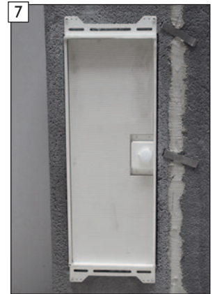
7 Fertigansicht mit vollständig eingebrachter Schutzdichtung.
