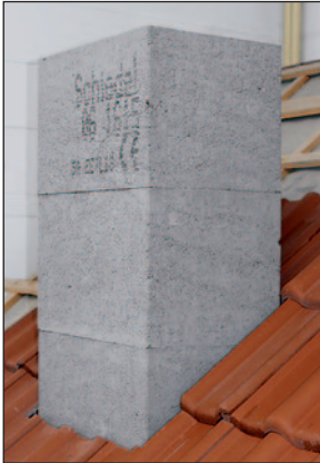
Ansicht vor Montagebeginn.
