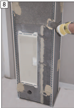
8 Anbringen der bauseitigen Putzschienen.
