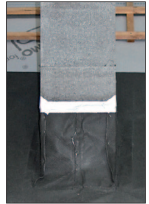
Bauseitiger Anschluss an USB-Folie
