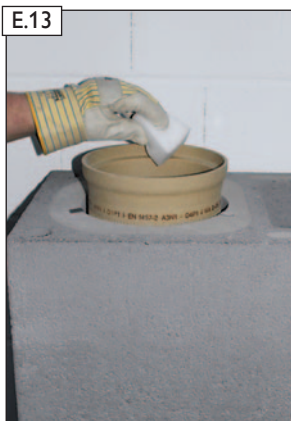
E.13 Steckverbindung säubern.
