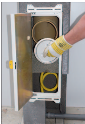
Design-Putztür öffnen und Revisionsverschluss abnehmen. (Bildarstellung am Beispiel Revisionsverschluss „B“)
