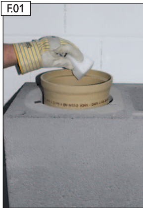
Steckverbindung säubern.
