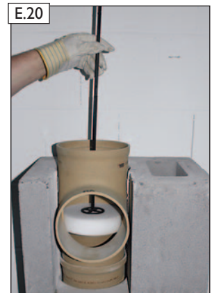
Reste von RAPID-fugendicht mit Fugenglätter abstreifen.
