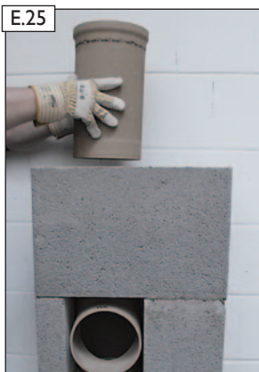
Profilrohr (L = 33 cm) einsetzen.
