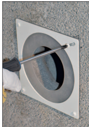
BlowerDoor Zuluftblende montieren.
