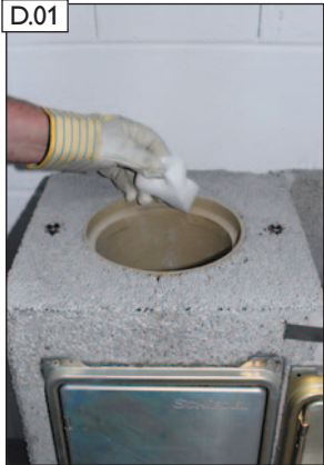
D.01 Steckverbindung säubern.
