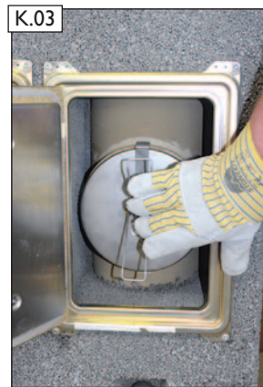
K.03 Revisionsverschluss bei Festbrennstoffbelegung.
