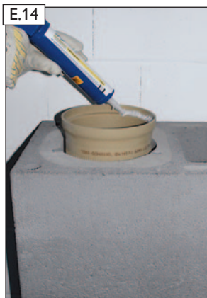
E.14 RAPID-fugendicht satt im Bereich der Steckverbindung des Profilrohres auftragen.
