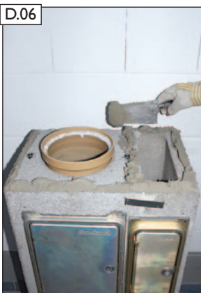
D.06 Dünnbettmörtel, auch im Stegbereich, auftragen.
