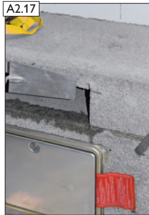
Überschnitte am Lüftungsmodul ebenfalls vollständig ausspachteln.
