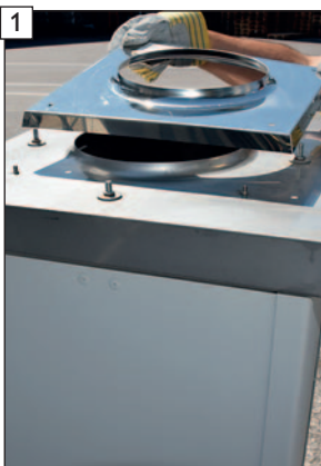
1 Adapterplatte auf Befestigungsbolzen auflegen.
