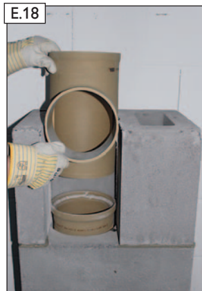
Rauchrohranschluss (RA) einsetzen. L = 33 cm bis \varnothing 20 cm L = 66 cm ab \varnothing 25 cm
