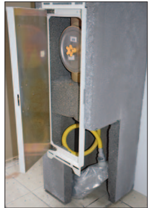
Fertigansicht mit angeschlossenem Kondensatauffangbeutel.
