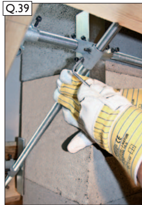
Q.39 Zuerst Sparrenhalter und Spannwinkel (siehe Bild Q.24 und Q.25), danach Spannkreuz fixieren. Abreißschrauben anziehen bis Schraubkopf an der Sollbruchstelle abreißt.
