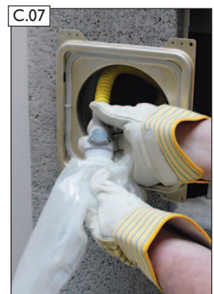
C.07 Kondensatauffangbeutel mit Kupplungsteil verbinden.
