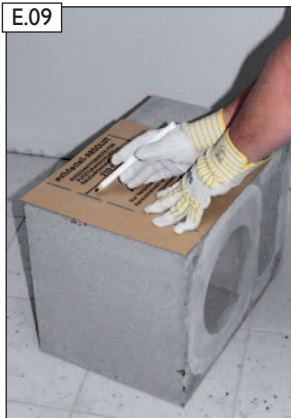
E.09 Schablone außen anlegen, Mantelsteinöffnung anzeichnen.
