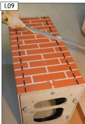
Der erforderliche Schräg- schnitt kann nun allseitig auf dem Stülpkopf ange- zeichnet werden.
