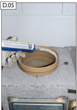
D.05 RAPID-fugendicht satt auf Adapterring auftragen.
