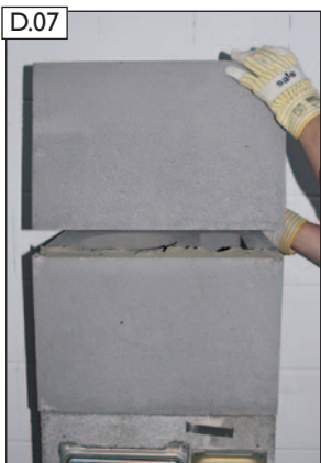
D.07 Weitere Mantelsteine gem. der gewünschten RA-Anschlusshöhe in Dünnbettmörtel versetzen.
