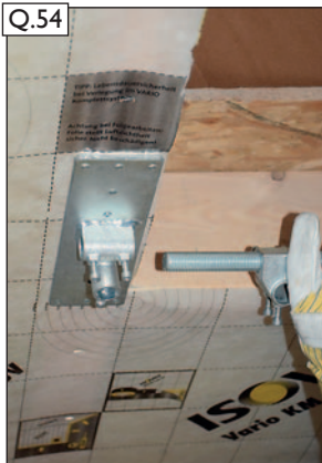
Q.54 Gewindestange und 45° Spannwinkel wieder einfädeln und ausrichten.
