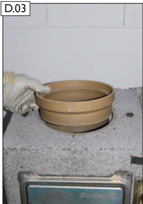
D.03 Adapterring einsetzen.
