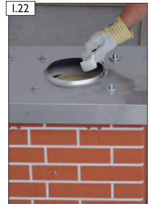
I.22 Steckverbindung säubern.
