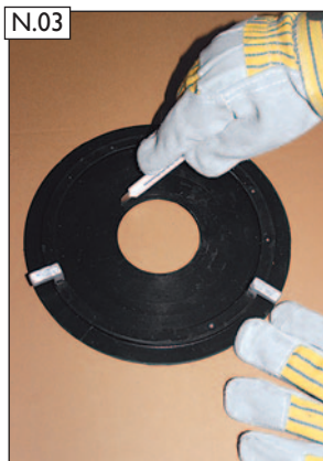
Innenöffnung des Steckadapters für die benötigte bauseitige Verbindungsleitung herstellen.
