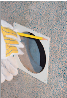
Markierung für Bohrlöcher anzeichnen und herstellen.
