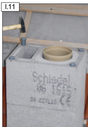
I.11 HEB-Spezialdübel in die Bewehrungskanäle einschlagen.
