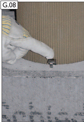
G.08 Abstandhalter (3 Stück) auf den Umfang verteilt in die integrierte Wärmedämmung aus Schaumbeton eindrücken.
