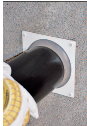
Bauseitige Zuluftleitung in BlowerDoor Zuluftblende einschieben.
