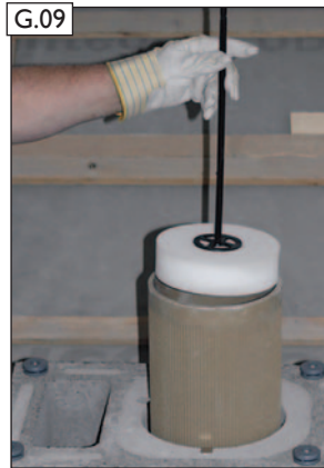
G.09 RAPID-Fugenkittreste abstreifen.
