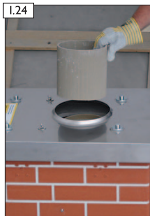
I.24 Zugeschnittenes Abschlussprofilrohr ersetzen.
