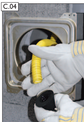
C.04 Adapter für HT-Rohrverbindung DN40 vom Siphonschlauch abschrauben.
