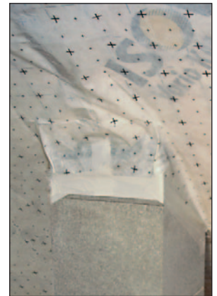
Bauseitiger Anschluss an DB-Folie
