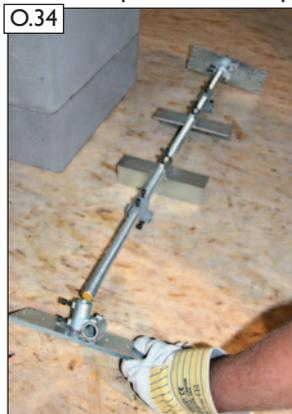
Vorarbeiten ausführen (siehe Bild O.18 bis O.20). Spannwinkel, Spannkreuze lose auf Gewindestange auffädeln und Sparrenhalter lose aufstecken.
