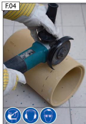
An der Nutseite des Schamotterohres anzeichnen und mit Winkelschleifer zuschneiden.
