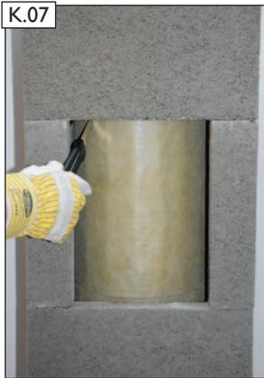
Vordere erreichbare Dämmstoffsicht mit Cuttermesser freischneiden.
