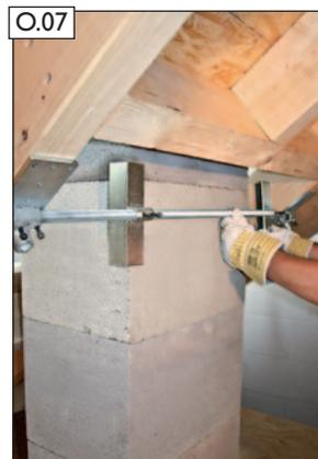
Spannwinkel an beiden Seiten ausrichten.
