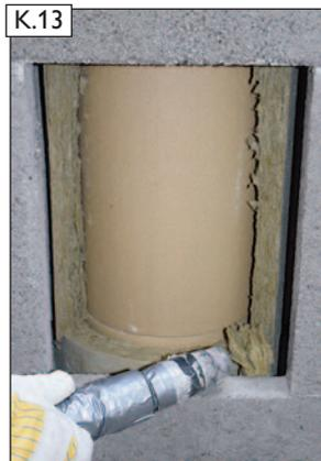
Zuluftkanäle von Dämmstoffresten freihalten.
