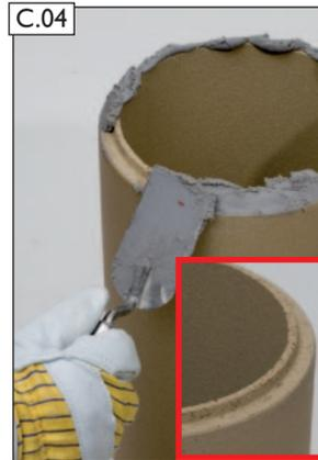
C.04 Fugenkitt auf Rohrunterseite auftragen.
