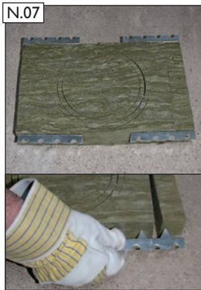
Haltewinkel in die BDF einstecken. Mit den oberen Haltewinkeln den angelegten BDF-Abschnitt fixieren.
