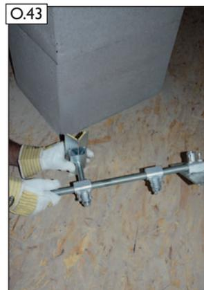
45° Spannwinkel in das mittlere Spannkreuz ein-stecken und leicht fixieren.
