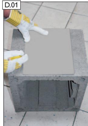
D.01 RA-Schnittschablone aus dem BlowerDoor Set außen anlegen, Mantelsteinöffnung anzeichnen.
