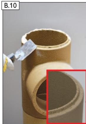
Fugenkitt auf Unterseite Rauchrohranschluss-Formstück (RA) auftragen.
