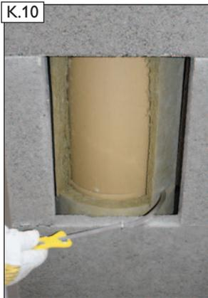
Das 1/4-Kreis Gelenk-Dämmstoffmesser ansetzen.
