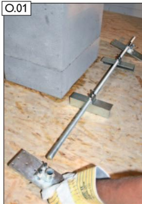
Ersten Schornsteinhalter vorbereiten. Spannwinkel und Sparrenhalter lose auf die Gewindestange auf-fädeln.
