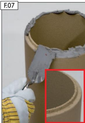
F07 Fugenkitt auf Rohrunterseite auftragen.
