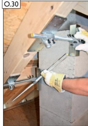
Gewindestange und Spannwinkel fixieren (siehe Bild O.08 und O.09). Zusätzliche Gewindestange in die Spannkreuze einfädeln.
