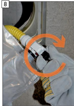
Verriegelung des BIB-Connectors im Uhrzeigersinn schließen.
