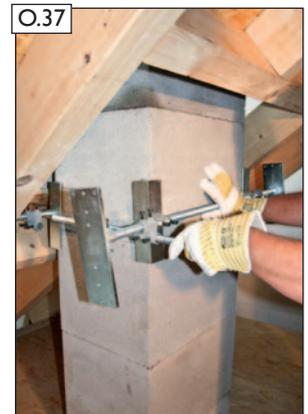
Lose aufgesteckte Sparrenhalter, Spannkreuze, Spannwinkel und Gewindestange in die Wechselöffnung einbringen.
