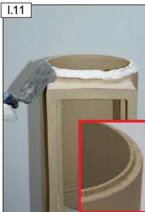
I.11 Fugenkitt auf Unterseite Rauchrohranschluss-Formstück (RA) auftragen.
