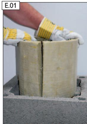
E.01 Dämmplatte biegen, einsetzen und nach unten schieben.
