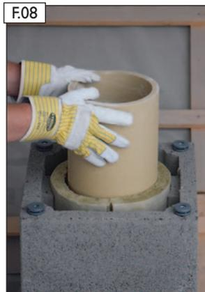
F08 Abschluss-Profilrohr (ohne Dämmschale) versetzen.
