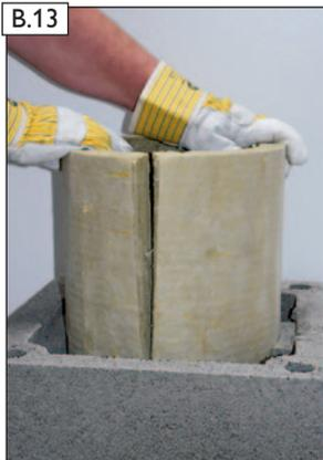
Dämmplatte biegen, einsetzen und nach unten schieben.
