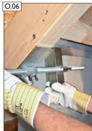
Gewindestange und Spannwinkel wieder einfädeln.
