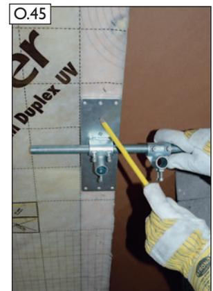
Einbauposition für den Sparrenhalter markieren. Danach Einzelteile aus-fädeln.
