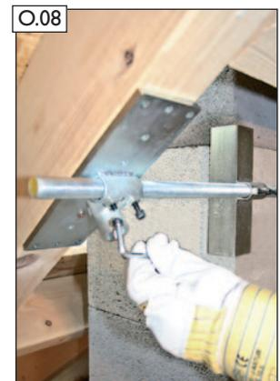
Gewindestange fixieren. Dazu die Abreißschrauben an beiden Sparrenhaltern mit Inbusschlüssel (E) anziehen bis der Schraubkopf an der Sollbruchstelle abreißt.
