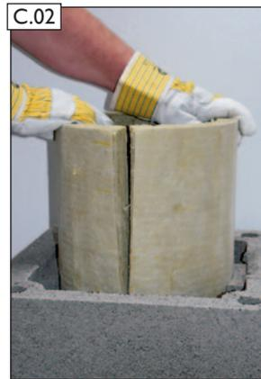
C.02 Dämmplatte biegen, einsetzen und nach unten schieben.
