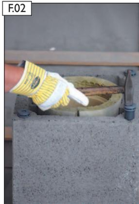
HEB-Spezialdübel in die Bewehrungskanäle des Mantelsteins einschlagen.
