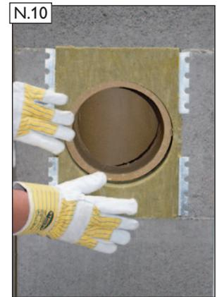
Jetzt die zugeschnittene BDF in die Mantelsteinöffnung einbringen und ...
