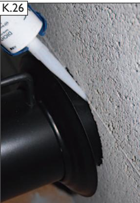
Die Zuluftleitung an der Öffnungsbohrung im Schornstein muss bauseitig mit Silikon abgedichtet werden.
