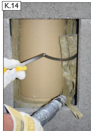
Seitlichen Dämmstoff mit dem 1/4-Kreis Dämmstoffschaber entfernen.
