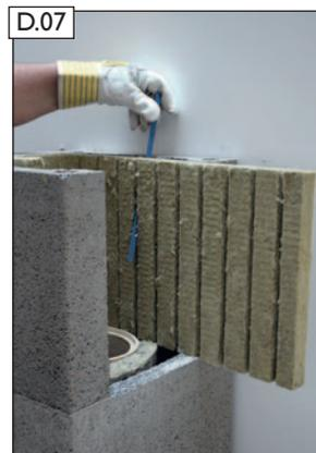
D.07 Dämmplatten einbringen und kürzen, Zuluftkanäle bleiben frei.
