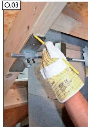
Einbauposition für den Sparrenhalter markieren. Danach Einzelteile ausfä-deln.
