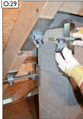
Sparrenhalter anbringen (siehe Bild O.01 bis O.05). Gewindestange, Spannwinkel und Spannkreuze wieder einfädeln.
