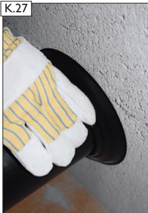
Anschlussrosette der Zuluftleitung an Schornstein anschließen.
