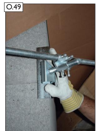
45° Spannwinkel ausrich-ten und vorfixieren.
