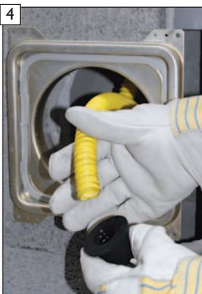
4 Adapter für HT-Rohrverbindung DN40 vom Siphonschlauch abschrauben.
