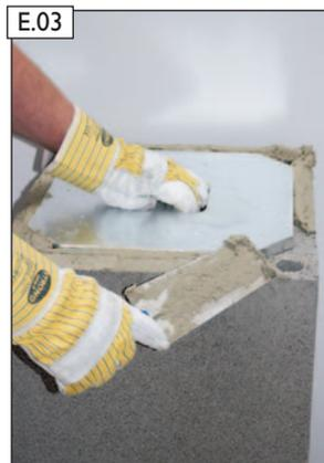
E.03 Mörtel MG(M5) IIa (Mauermörtel nach EN 998-2) mit Versetzschablone auf Mantelstein auftragen.
