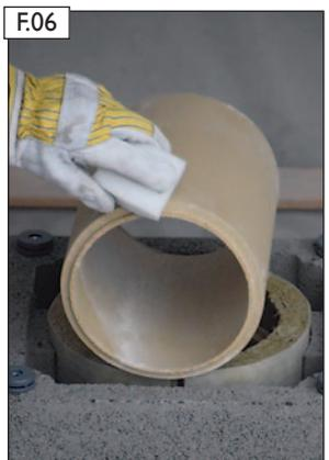
Unterseite des zugeschnittenen Abschlussrohres säubern.
