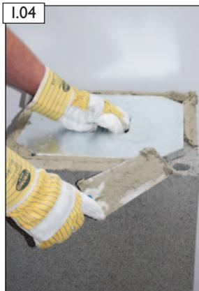
Mörtel MG(M5) IIa (Mauermörtel nach EN 998-2) mit Versetzschablone auf Mantelstein auftragen.
