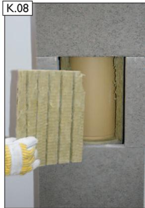
Dämmstoffsicht vollständig entfernen.
