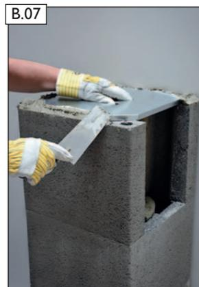
Mörtel MG(M5) Ila (Mauermörtel nach EN 998-2) mit Versetzschablone auf Mantelstein auftragen.
