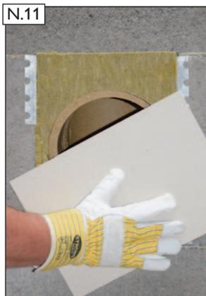
... mit Hilfe der Schnittschablone (als Einschubhilfe) bündig zum Mantelstein einsetzen.
