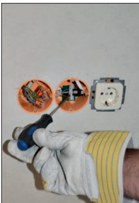
Klemmstelle für LEDA LUC Verbinder
