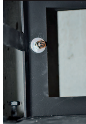
Ansicht der werkseitig verbauten Potentialausgleichsanschlussklemme.
