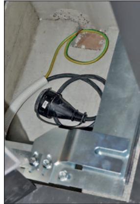
Ansicht vor Montagebeginn.
