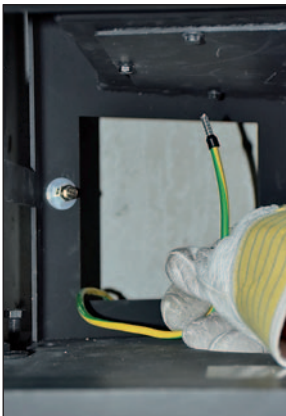
Bauseitiger Potentialausgleichsleiter „herausangel“ und hinter der Geräterückseite zur Potentialausgleichsanschlussklemme führen.
