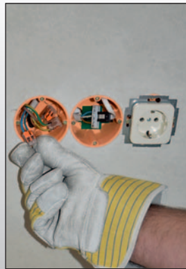
Klemmstelle für Flexkabel 230V
