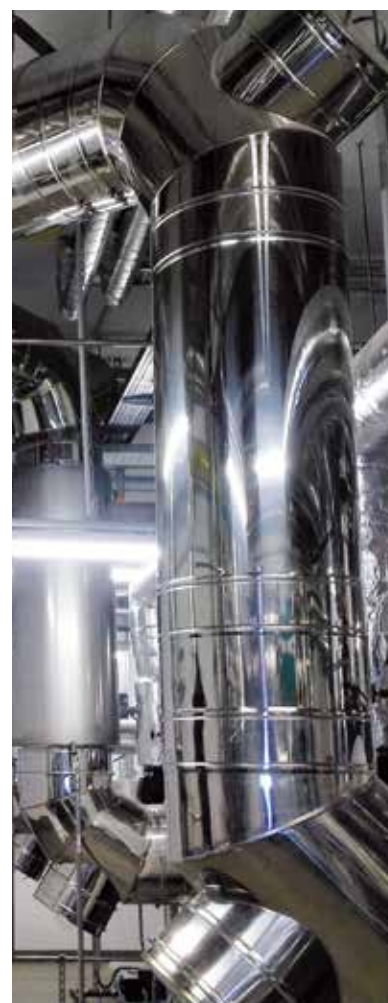
Esempio di impianto fumario Super ICS asservito a centrale termica, struttura ospedaliera.
