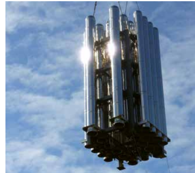
Sistemi camino ICS e ICS 5000 con struttura traliccio prefabbricata Struttura ospedaliera, UK
