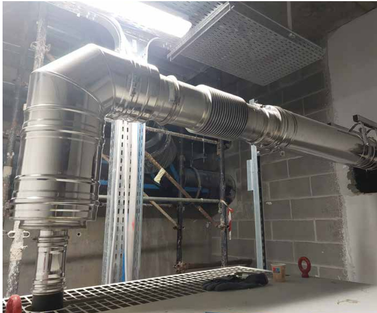
Sistema ICS 5000. Gruppo elettrogeno per motopompa antincendio, edificio multipiano, Milano
