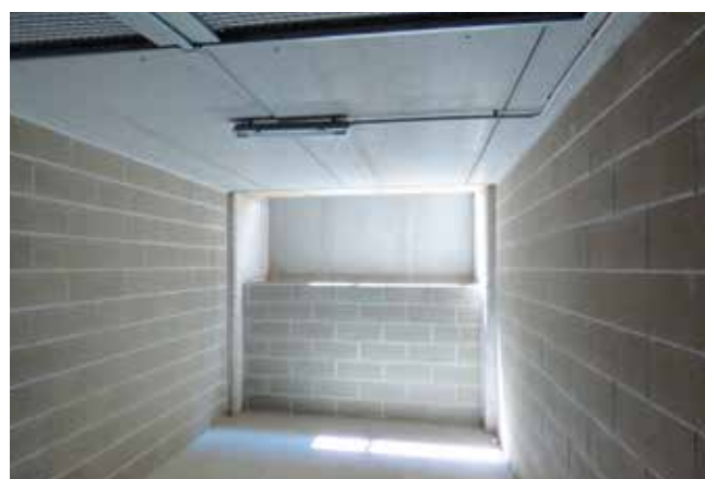
Dettaglio box singolo dotato di idonea paratia di ventilazione piano -1
