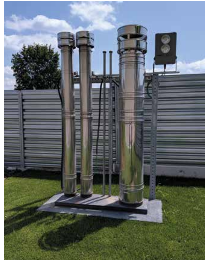
Sistema ICS 5000 e HP5000 Impianto asservito a motopompe antincendio. Sede direzionale telecomunicazioni, Milano
