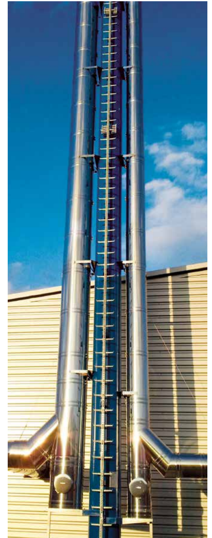
Sistema camino ICS Impianto multiplo con traliccio di supporto Caserma militare, Germania
