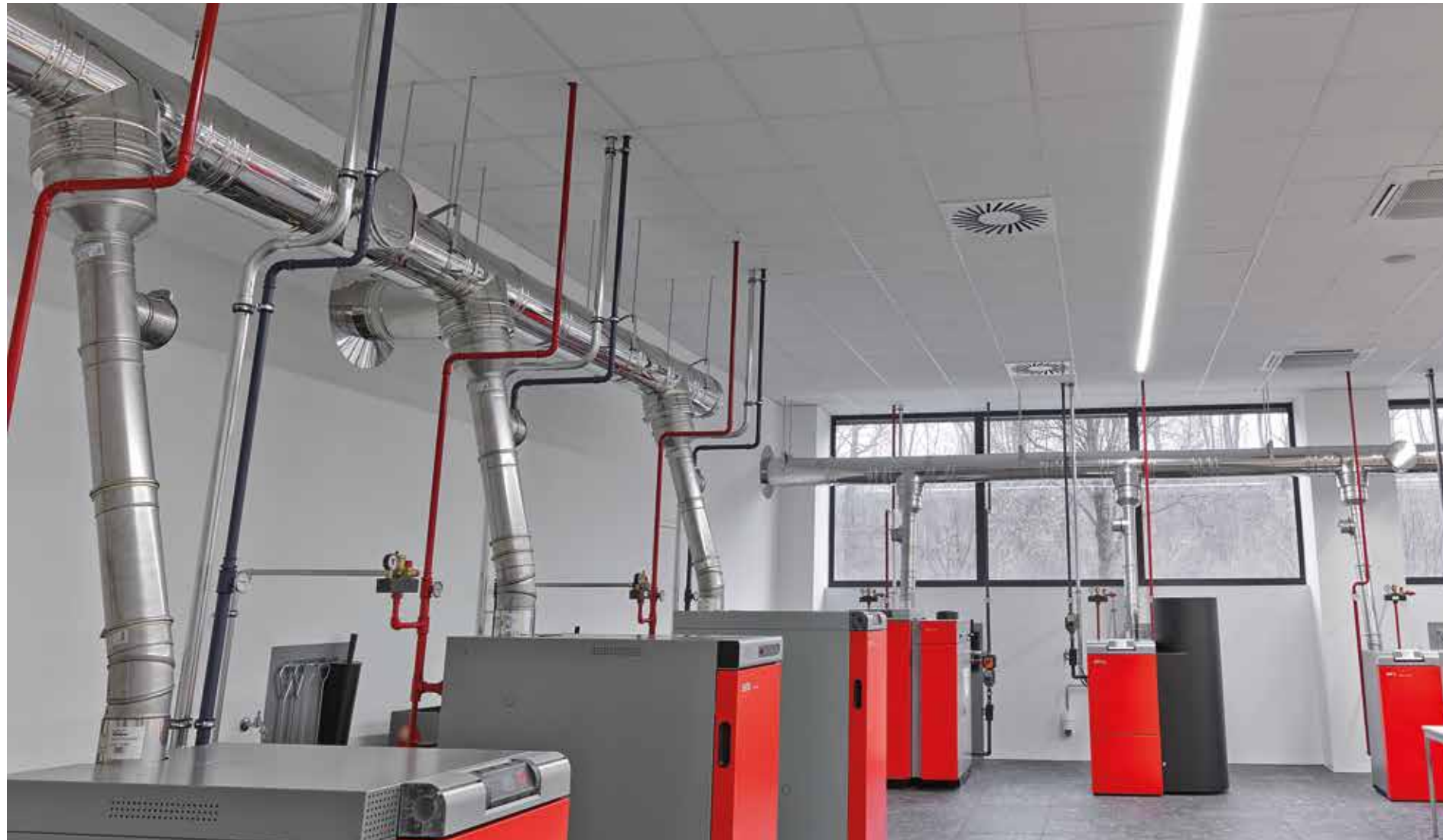
Sistema camino - ICS e mono parete Prima Plus. Impianto a cascata. Generatori a biomassa, Austria
