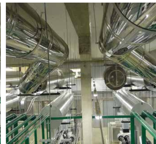
Esempi di applicazioni di canne fumarie e condotti resistenti al fuoco in ambienti compartimentati
