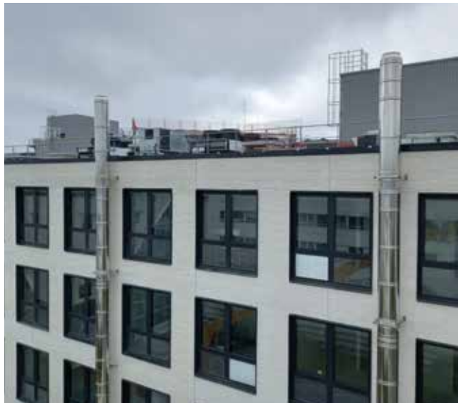
Sistema camino - ICS 5000 isolamento 50 mm Struttura ospedaliera Francia
