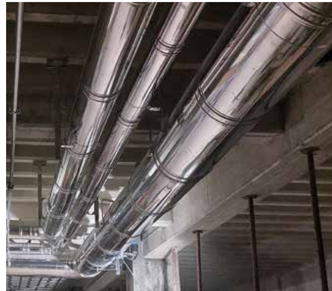
Sistemi Super ICS e ICS 5000. Impianto multiplo per gruppi elettrogeni, motopompe antincendio, cappe cucina, edificio multipiano, Milano
