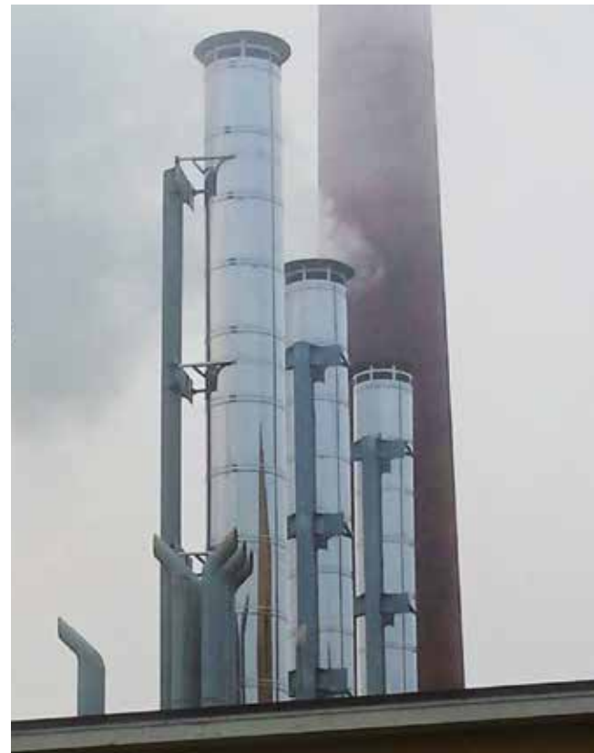
Sistema Super ICS Impianto multiplo Struttura ospedaliera, Pavia
