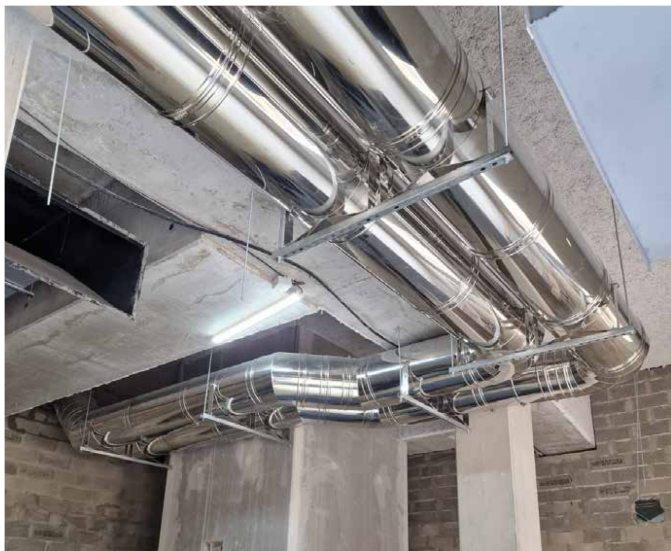
Sistema camino ICS 5000 in applicazione EI120 Vano tecnico in edificio pubblico, Francia
