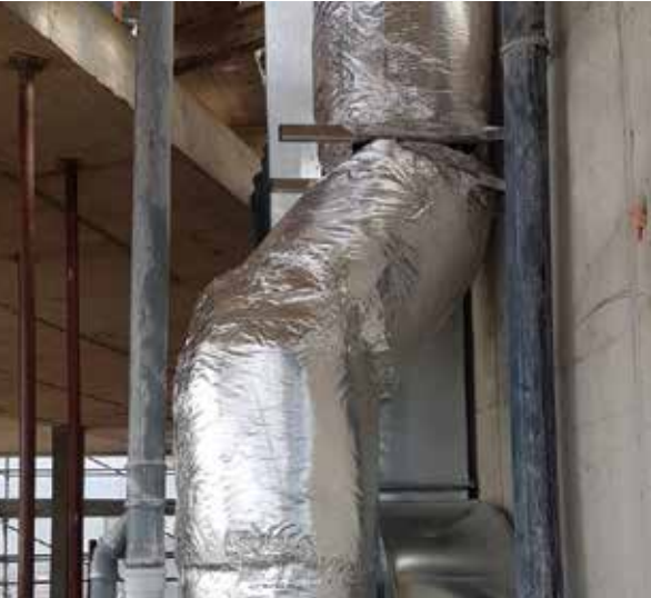
Esempio di canna collettiva ramificata a servizio di vano filtro a prova di fumo
