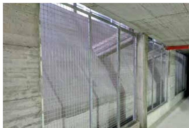
Dettaglio posti auto dotati di idonea paratia di ventilazione, con griglia di protezione
