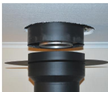
Dekkringen/dekkplaten skjuler hullet i himling/gulv og festes med medfølgende skruer rundt pipa i bjelkelaget. Avstanden mellom dekkring og rørlengdene tette med varmebestandig silicon. Husk å montere dekkringen før neste rørlengde monteres. I gjennomføringen av dampsprenn benyttes en tettemansjett, se side 6. Isolasjon av ikke brennbart materiale fylles rundt pipa i bjelkelaget.
