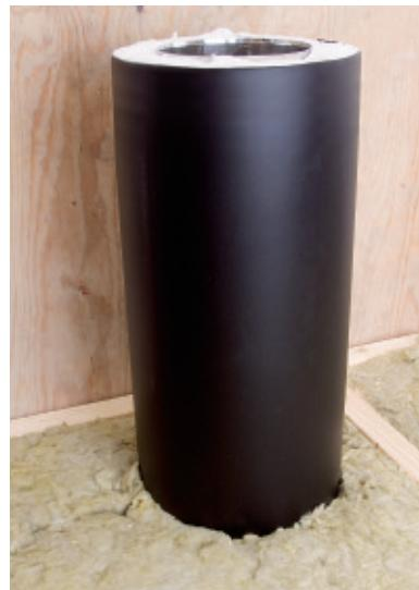
Dampsperren er nå tettet og videre montering gjennom yttertaket kan fortsette. På den pipelengden som monteres gjennom yttertaket tres det også på en tettemansjett. Dette for å sikre mot lekkasje av kondensvann som kan dannes på pipelengdene over tak.
