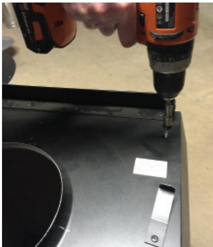
Avdekningen festes til den øvre teleskopdelen med de 4 medfølgende pakningskruene.
