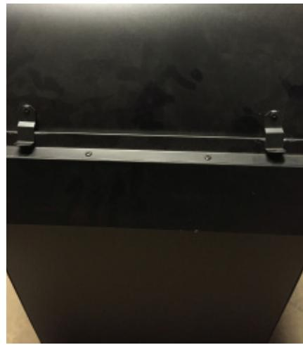
Pipehatten festes til skinnen på toppavdekningen og sikres med de to låsebeslagene som er festet på pipehatten.
