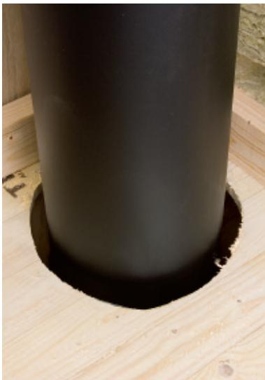
Gjennomføring av pipe i innertak med dampssperre. Sørg for en minsteavstand på 50 mm til brennbart materiale. Før videre montering tres tettemansjetten på piperøret.
