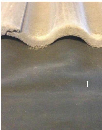
Gummiduken i bakkant på overbeslaget monteres under takstein. Hvis det er monert takplater i hele takets lengde og gummiduken ikke rekker opp til møne, må denne skjøtes med wakaflex eller lignende materiale. Alternativt monteres en ny takplate fra møne og ned over gummiduken, for å sikre nødvendig tetthet mot vanninntrenging.
