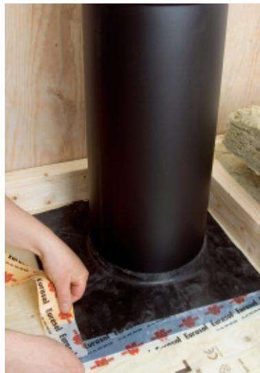
I dette tilfellet monteres tettemansjetten på gulvet, men den kan også monteres direkte på dampssperren. Mansjetten kan tilpasses ønsket bredde og tapes fast med vedlagt tape.
