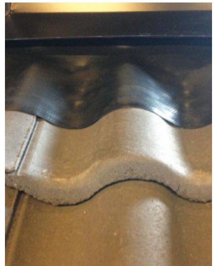
Dekkplasten på wakaflex demonteres og wakaflex formas ned i profilen på takstein/-takplatene.
