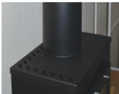
Pipen skal alltid monteres med hunndelen ned. Hunndelens yttermantel har en grad utover og innermantelen har en grad innover. Utsparingsmålet for helisolert er 350 mm.
