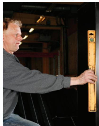
Den nedre delen av teleskopbeslaget plasseres over beslaget og sørge for at dette står i lodd for det festes i overbeslaget og underbeslaget med 2 av de medfølgende sorte pakningsskruene. Vi anbefaler at det bores hull med et 2 mm bor først, da skruene skal gjennom mange lag med stålplater.
