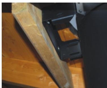
Vi anbefaler at det monteres en forankring mellom taksperrene. Hvis pipa går gjennom mer enn 2 etasjer bør det monteres en forankring i annenhver etasje.
