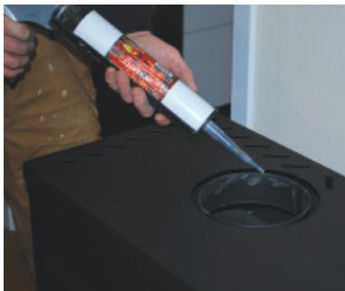
Start med å plassere startkoblingen på ildstedet og fest denne med flytende fiberpakning eller ovnskitt. Ved behov kan startkoblingen kappes i nedkant for å få ønsket avstand mellom pipe og ildsted. Det anbefales og benytte startkobling isolert dersom bunnen av skorsteinen utsettes for høy varme. Også ved skorsteiner med lyse farger.
