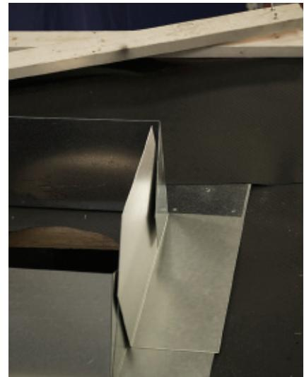
Ta bort takstein/takplater og marker hvor senter på skorsteinsrøret skal være. Ta bort lekter og sløyfer i et område på ca 1 kvm før man skjærer hull i undertaket. Monter skorsteinsrøret slik at det stikker minimum 500 mm over yttertaket. Kubbe imellom takstolene som vist på bilde for å få et solid underlag for feste av underbeslaget.
