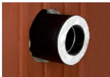
Plasser ovnen mot veggens metall-/glassplater under. Det enkleste er å tegne rundt røykrøret. Alternativt kan man måle sentrum på røykrøret og så tegne på veggens. Mål hvor stor diameteren på hullet ble og del det på to for å få radien. Legg så til 50 mm. Mål inn summen på en liten lekt og slå igjennom en spiker. Du har nå fått en passer med det målet som kreves for at røykrøret brannsikkert skal kunne føres gjennom veggene. Bruk blyant å tegne med.
