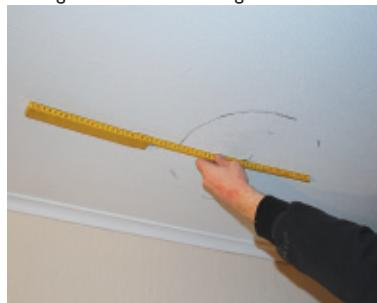
Enkel isolerte rørlengder benyttes fra ildstedet og opp til 150 mm under himling. Hullet i himling/- gulv skal alltid være minimum 100 mm større enn utvendig pipemål.
