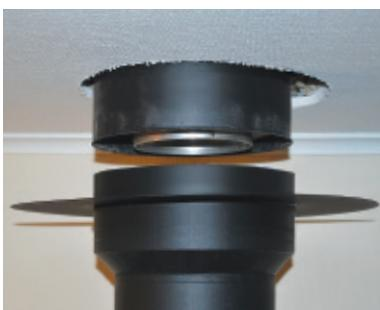
Dekkringen/dekkplaten skjuler hullet og festes med medfølgende skruer. Avstanden mellom dekkringen og rørlengdene tettes med varmebestandig silicon eller en egnet gummilist. Husk å tre dekkringen på den nedre rørlengden før neste rørlengde monteres. I gjennomføringen av dampsperrer benyttes en tettemansjett, se side 6. Isolasjon av ikke brennbart materiale fylles rundt pipa i bjelkelaget.
