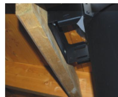
Vi anbefaler at det monteres en veggforankring i taksperrene og en takforankring på undertaket for å stabilisere pipa over tak. Blir pipa høyere enn 1600 mm over tak bør det monteres et wirefeste eller støttestag komplett (gjelder kun ved rund løsning over tak).
