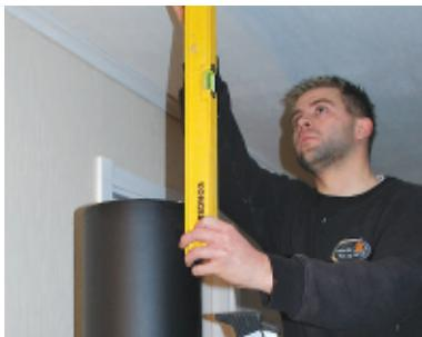
Benytt et vater og merk av piperørets omkrets i taket og sett et kryss i senter. Utsparingsmålet for enkel isolert er 350 mm.
