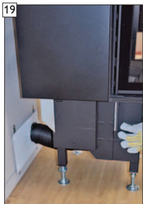
19 Posuňte spaľovaciu komoru do konečnej polohy k stene a vyrovnejte ju podľa montážneho návodu.
