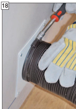
18 Pevne ju upevnite na výstupok koncentrickej pripojovacej mriežky.
