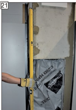
21 Vyrovnajte rohové profily kolmo.
