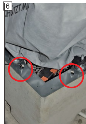
6 Rovnako uvoľníte obe upevňovacie skrutky na spodnom omietkovom uhle.
