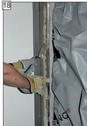
18 ... vľavo pomocou spojovacieho mostíka „maxit multi 280“ a vyrovnajte ich.
