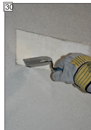
30 Pohľad na „rez“ pri otvore pre konvekčný vzduch.
