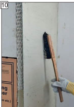
10 Na povrch vytvorte drážky pre neskoršiu nanášanie vrchného náteru pomocou spojovacieho mostíka (napr. omietkovou kefou).
