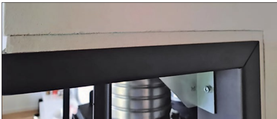
Vzhľad po dokončení s namontovaným rámom
