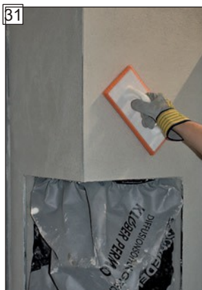
31 Povrch obrúsiť alebo štruktúrovať.
