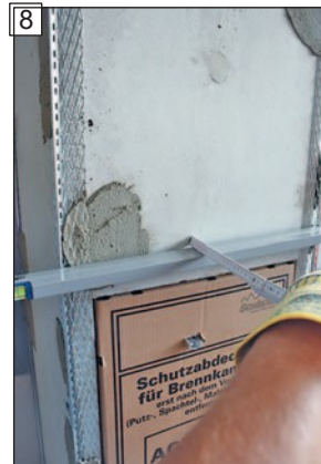
8 Skontrolujte požadovanú hrúbku stierky podľa toho nastavte rohové a spojovacie profily.
