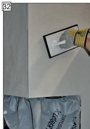
32 V prípade potreby povrch následne vyfilcovať.
