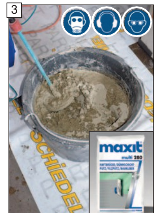
Pripraviť adhézný mostík „maxit multi 280“ podľa pokynov výrobcu.
