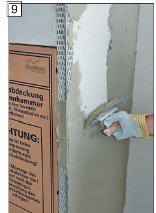
9 Naneste spojovací mostík – max. hrúbka vrstvy 5 mm.
