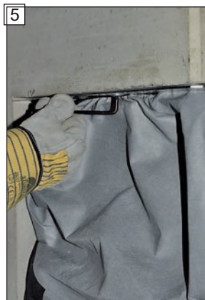
5 ... ľavú upevňovaciu skrutku na hornom omietkovom úhle uvoľníte o 2–3 otáčky.
