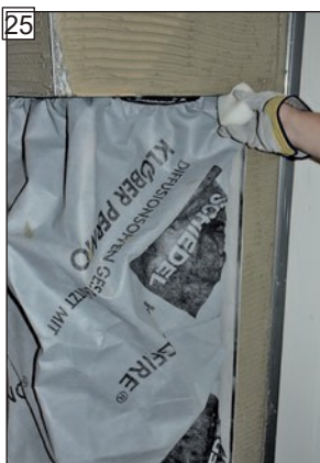
25 Pripojovacie profily a hrany rohových listů očistite ešte v mokrom stave.
