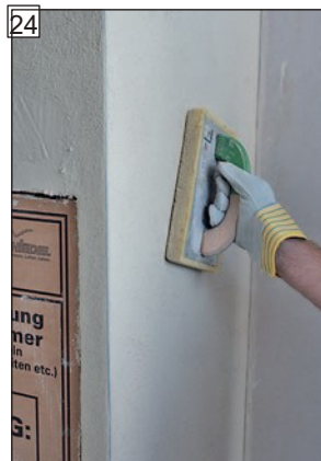
24 V prípade potreby povrch následne zafiltrovať.
