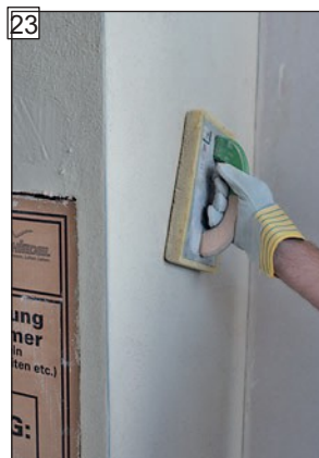
V prípade potreby povrch následne zfilcovať.
