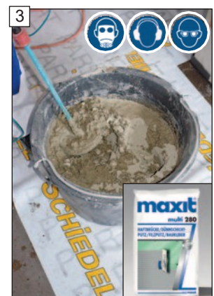
Pripraviť adhézný mostík „maxit multi 280“ podľa pokynov výrobcu. POZOR! Dodržiavajte pokyny týkajúce sa bezpečnosti pri práci na strane 2!
