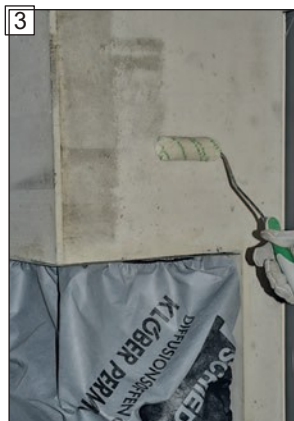
3 Predčistenie betónového plášťa vodou na zviazanie prachu (napr. pomocou maliarskeho valčeka).
