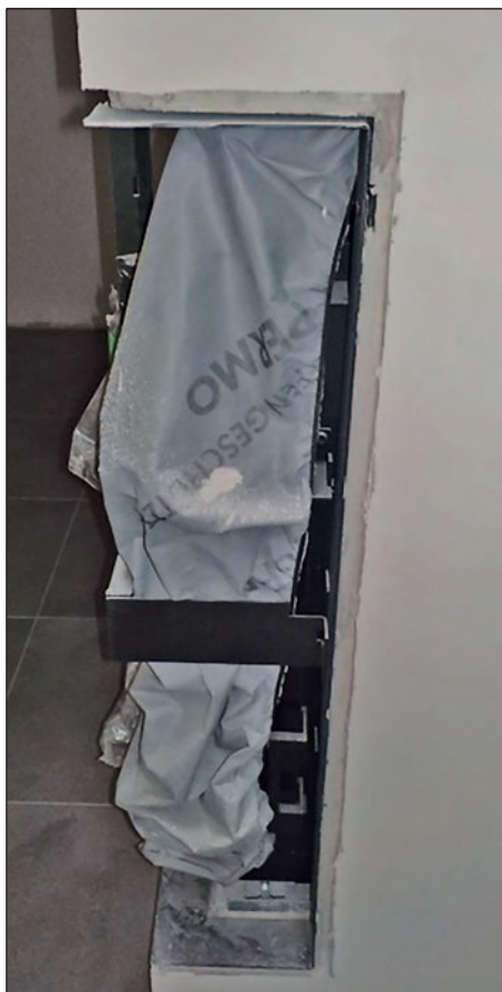
Pohľad po vykonaní obvodového výrezu na strane staviteľa
