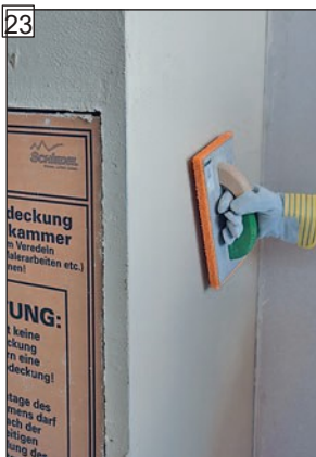
23 Povrch obrúsiť alebo štruktúrovať.
