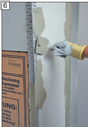
6 Rohové profily pripevnite pomocou spojovacieho mostíka „maxit multi 280“ a vyrovnajte.
