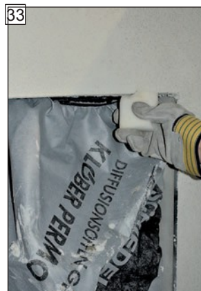
33 Čistiť spojovacie profily ešte vo vlhkom stave.
