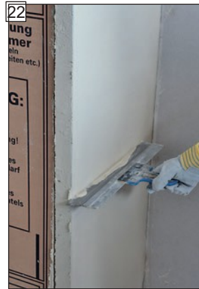
22 V prípade potreby povrch dopracujte špachtľou.
