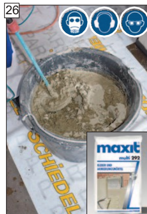
26 Zmiešajte vrchnú omietku „maxit multi 292“ podľa pokynov výrobcu.
