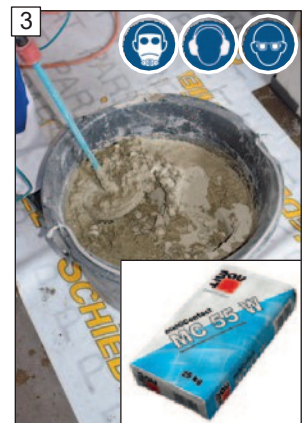
Pripraviť adhézy „Baumit multiContact MC 55 W“ podľa pokynov výrobcu. POZOR! Dodržiavajte pokyny týkajúce sa bezpečnosti pri práci na strane 2!
