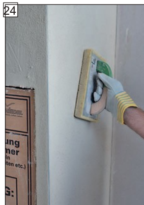
24 V prípade potreby povrch následne zfilcovať.
