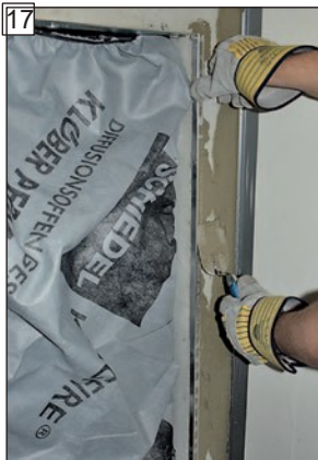
17 Pripojovacie profily na strane stavby k otvoru spaľovacej komory spravo a ...
