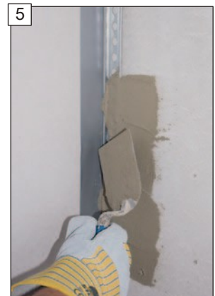
Pripojovacie profily s Naneste a vyrovnajte adhézy „Baumit multiContact MC 55 W“.
