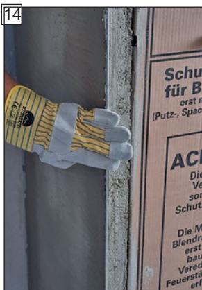
14 Hrany rohových listů očistite ešte v mokrom stave.
