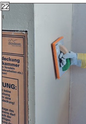
Povrch obrúsiť alebo štruktúrovať.
