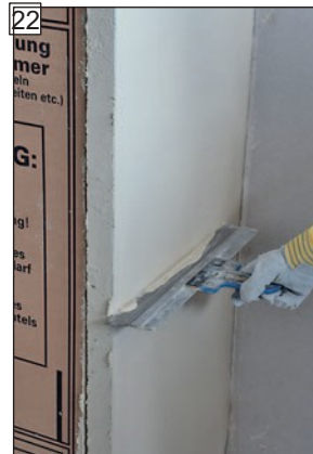
22 V prípade potreby povrch dodatočne opracujte špachtľou.
