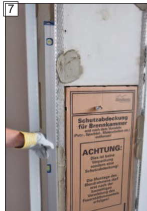
7 Rohové profily vyrovnajte kolmo.
