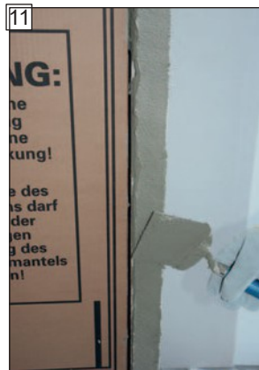
11 Naneste spojovací mostík na otvory, ...
