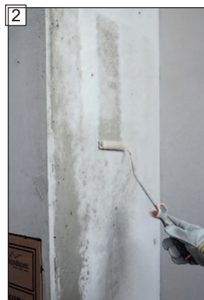
Predčistenie betónového plášťa vodou na zviazanie prachu (napr. pomocou maliarskeho valčeka).
