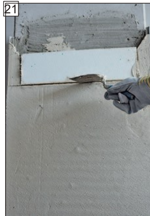
Pohľad na „rez“ pri otvore pre konvekčný vzduch.
