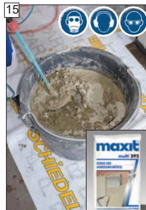
15 Zmiešajte povrchovú stierku „maxit multi 292“ podľa pokynov výrobcu. POZOR! Dodržiavajte pokyny týkajúce sa bezpečnosti pri práci na strane 2!
