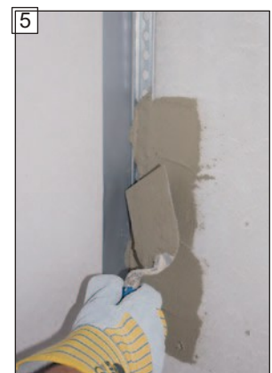
Pripojovacie profily s Naneste a vyrovnajte spojovací mostík „maxit multi 280“.
