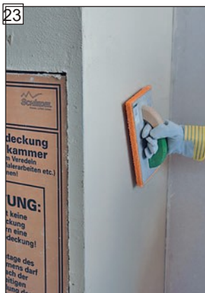
23 Povrch obrúsiť alebo štruktúrovať.
