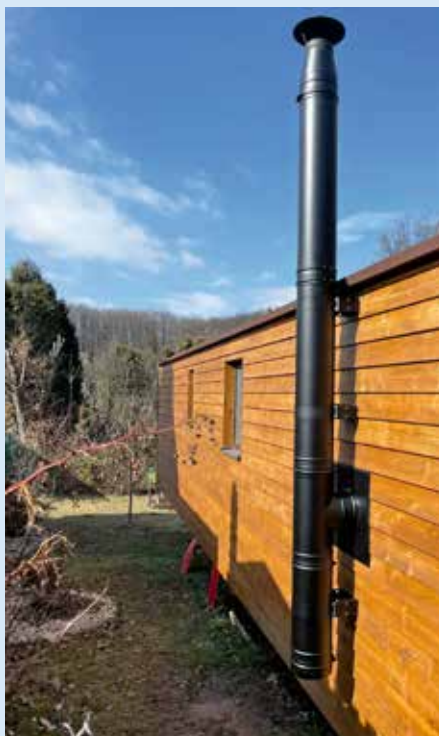
Realizácia viacvrstvého komínového telesa Schiedel Perimeter na fasáde chatky s realizáciou prístupu dymovodu cez stenu požiarne bezpečným prístupom Schiedel WDS.
