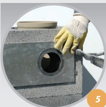
Učvršćenje vanjskog adaptera
