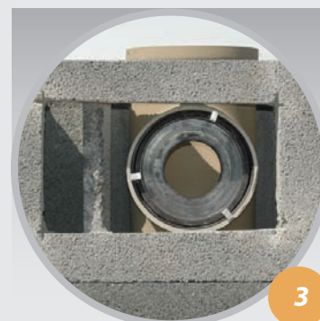
Ugradnja unutarnjeg adaptera
