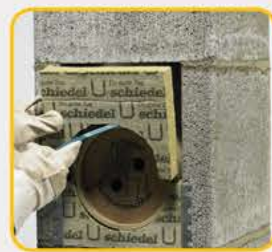
19 Postaviti prednju izolaciju oko priključka
