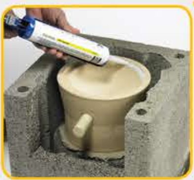
6 Nanijeti RAPID kit za spajanje cijevi
