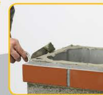
35 Nanijeti ljepilo za spajanje finalnih elemenata
