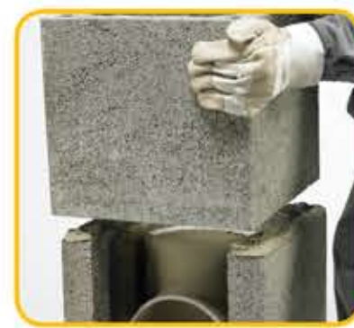
14 Pomoću šablone nanijeti mort i postaviti slijedeći plašt
