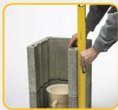
8 Postaviti slijedeći plašt, provjeriti okomitost
