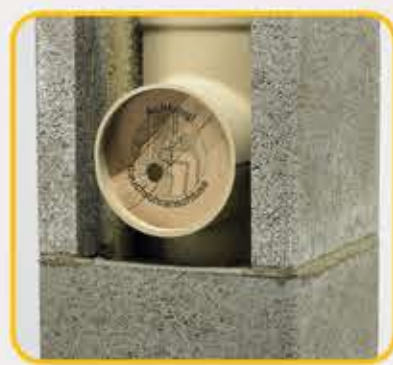
18 Pomoću kartona zaštititi otvor priključka
