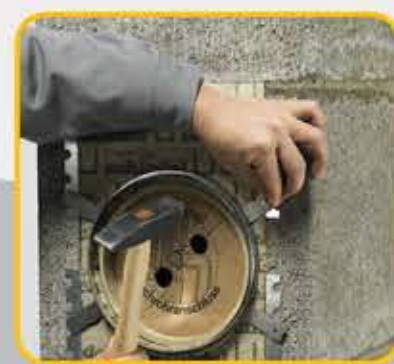
22 Montirati i učvrstiti prsten oko priključka
