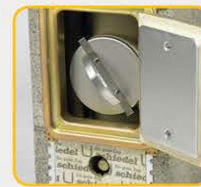
27 Provjeriti nesmetanost otvaranja-zatvaranja vratašca
