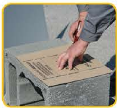
2 Na drugom plaštu pomoću šablone označiti otvor za vratašca
