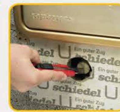
28 Osloboditi otvor za ispuš kondenzata na posudi za kondenzat
