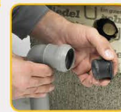
29 Pripremiti potrebne dijelove za spajanje odvoda kondenzata
