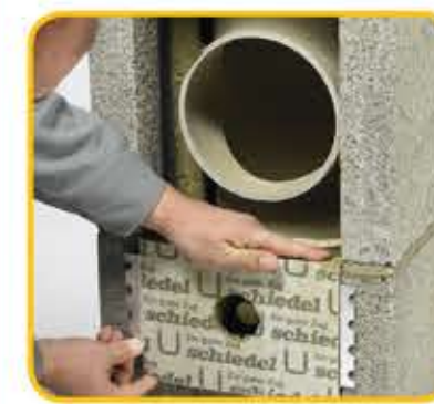
24 Na ploči izrezati otvor za spajanje odvoda kondenzata
