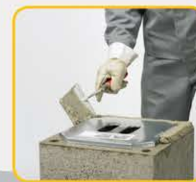
33 Na posljednji plašt prije montaže finalnih elemenata, pomoću šablone nanijeti mort
