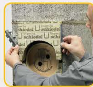
20 Prednju izolaciju učvrstiti nosačima termola
