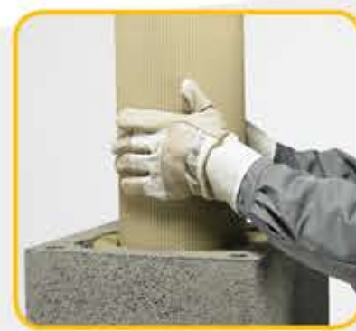
16 Umetnuti proliranu keramičku cijev
