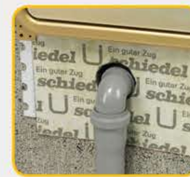
30 Spojiti odvod za kondenzat
