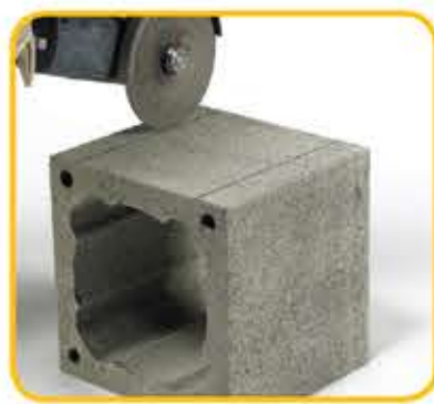
2a Izrezati otvor za vratašca pomoću kutne brusilice (pridržavati se mjera zaštite na radu-zaštita ociju, sluha i dišnih organa)
