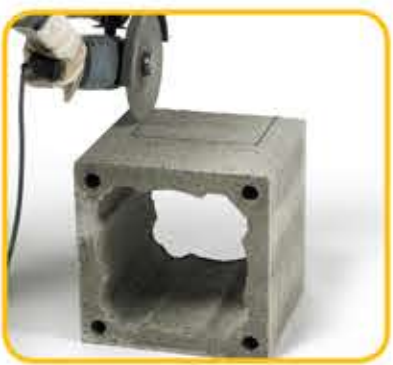
1 Na plaštu označiti i izrezati otvor 21x21 cm
