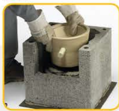
5 Postaviti posudu za kondenzat na mort
