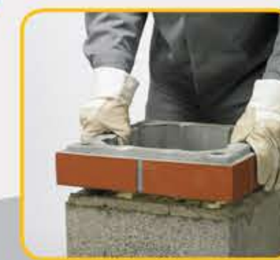
34 Montirati prvi finalni element (ako se završetak dimnjaka radi sa finalnim elementima)
