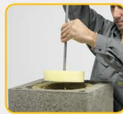
17 Pomoću pribora očistiti eventualno istisnuti kit na unutrašnjosti cijevi
