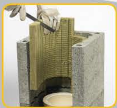
10 Izrezati izolaciju na potrebnu dimenziju (do kanala za provjetranje)
