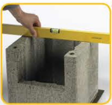
3 Prvi plašt postaviti na hidroizolacijsku podlogu, provjeriti vodoravnost plašta
