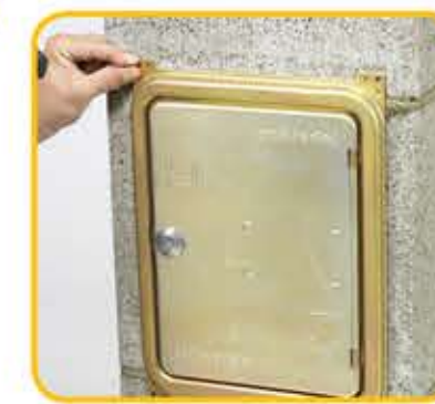
25 Montirati i učvrstiti vratašca na plašt
