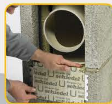
23 Kod posude kondenzata postaviti izolacijsku ploču
