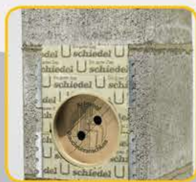
21 Poravnati prednju izolaciju oko priključka
