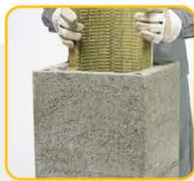
15 Umetnuti izolaciju (paziti da se izolacija spaja na sredini plašta)
