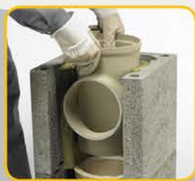
11 Postaviti priključak za reviziju-čišćenje
