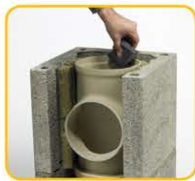
12 Očistiti utor priključka od prašine i nečistoće
