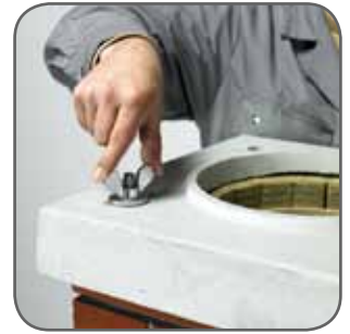
4.8 A fedkövet a tömítőalátét elhelyezése után, rögzítsük a szárnyas-anyákkal. A két másik furatot tömítősapkával zárjuk le.
