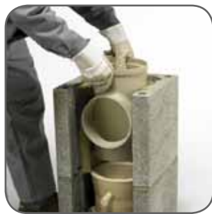
2.6 Be kell helyezni a tisztítóajtó-csatlakozó idomot.
