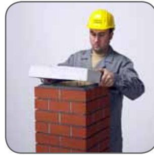
4.7 Az utolsó kéményfej elemre hordjunk fel habarcsot és tegyük fel a könnyű-beton fedkövet.
