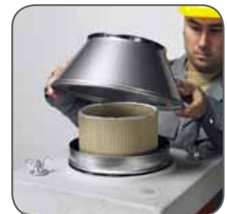
4.16 A fedlapra helyezve illesszük a helyére a torkolati kúpot.
