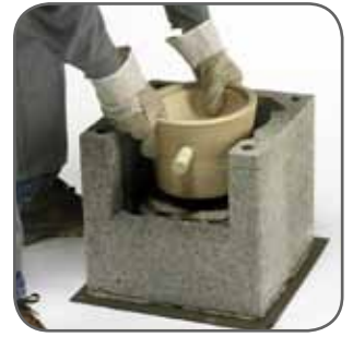
1.4 Habarcsba ültetve tegyük rá a kondenzvíz-gyűjtő lábazati téglát. A kondenzvizet a nyílás felé kell elvezetni. A kondenzvíz-gyűjtő lábazati téglá peremére nyomjunk samott-ragasztót.
