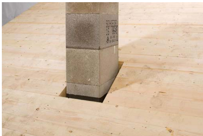
Prechod komínového telesa strechou
