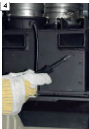
4 Odskrutkujte upevňovacie skrutky na kryte otvoru.
