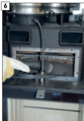
6 Rozdeľovač vzduchu vyčistite, povysávajte nečistoty.
