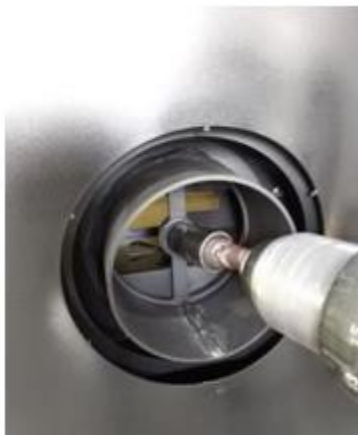
Uchytenie prívodu vzduchu skrutkou M8
