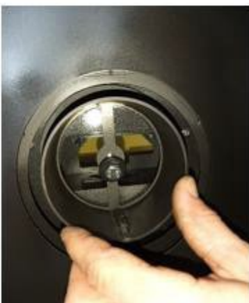
Ukážka montáže, uchytenia prívodu vzduchu
